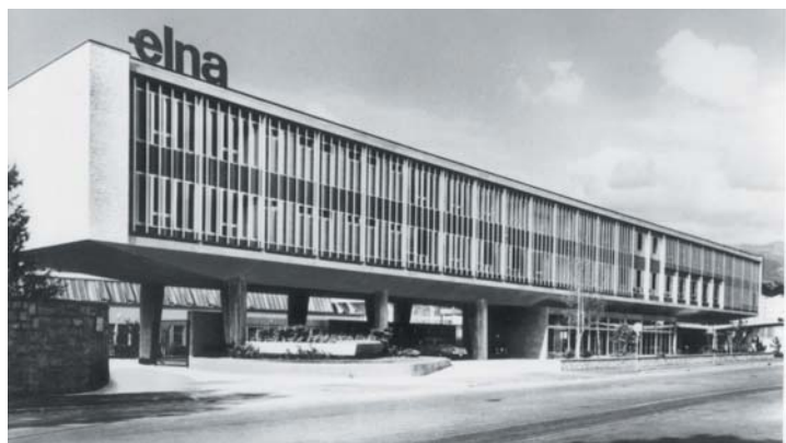
Le bâtiment administratif de Tavano, objet de la demande de classement.
