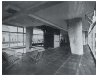
Les pilotis bruts de décofrage d'expression brutaliste (Bauen+Wohnen).
