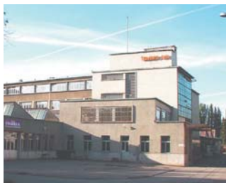
Vue du bâtiment de montage depuis le nord. Au premier plan, le «shed expédition» (à gauche) et le corps abritant l'arrivée (SMS).
