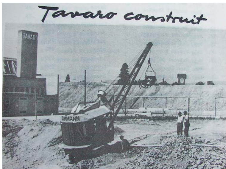
Tavaró 1947, démarrage du chantier. A gauche, les ateliers à sheds, surmontés par la première enseigne de l'entreprise (Elna Bulletin, 6, novembre 1946).
