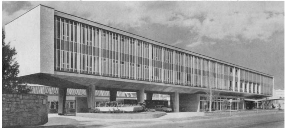
La structure sur pilotis répond habilement aux exigences fonctionnelles d'une usine (accès aisés des marchandises) tout en assurant la transparence sur le jardin aménagé en écran à l'usine, 1958 (Bauen+Wohnen).
