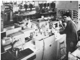
Une des « machines transfert », capable d'usiner quatre bâtis simultanément.
