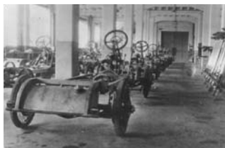
Piccard, Pictet & Cie, bâtiment de montage, 1920. Assemblage de la première série de 500 châssis. Le plan allongé et la structure ponctuelle permettent la mise en place de trois lignes de production (CIG et, en haut, AEG).
