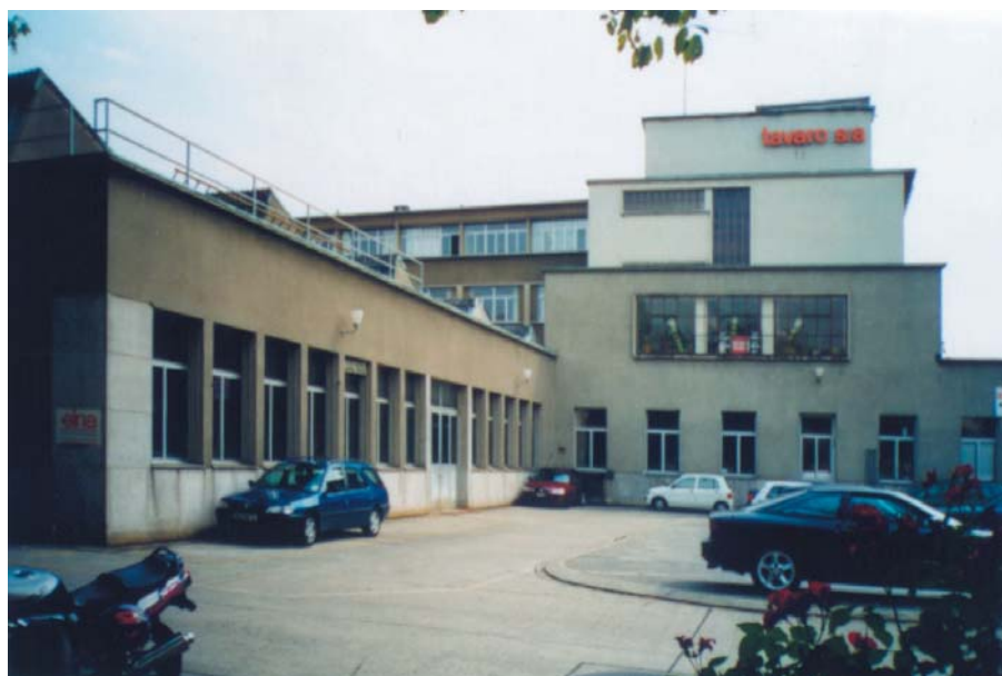
A l'arrière du bâtiment administratif, l'unité de production, un ensemble de corps imbriqués, fonctionnellement dépendants, abritant l'arrivage, l'expédition, les magasins, les ateliers de fabrication et ceux de montage.
