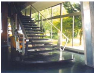
Détail de l'escalier aérien en plaques de marbre. Les main-courante sont en aluminium (SMS).
