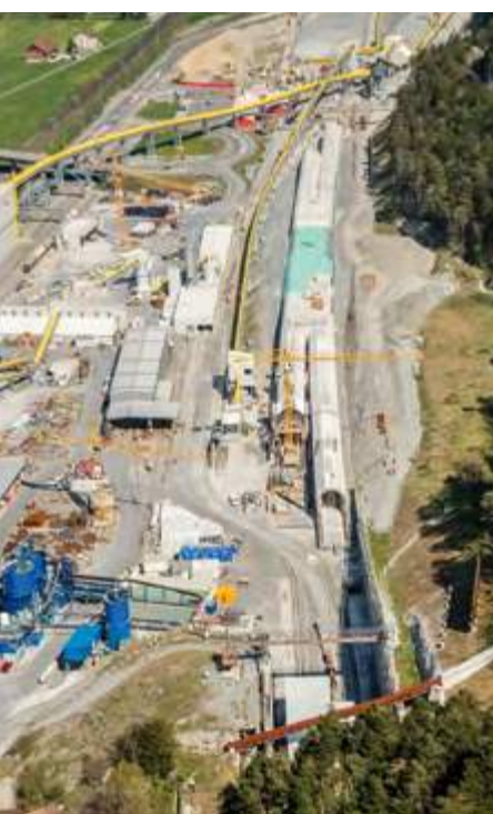
← Gotthard-Basistunnel; Installationsplatz Erstfeld 2010. Quelle: A. Wildbolz, ATG. Gotthard Base Tunnel; installation site Erstfeld 2010. Source: A. Wildbolz, ATG.
