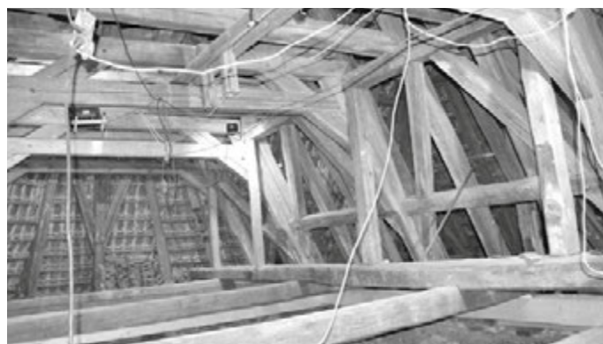
Konstrukce krovu při pohledu z půdy kostela
