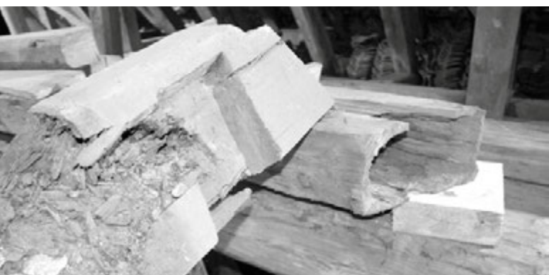
Trámy napadené hnilobou a dřevomorkou
