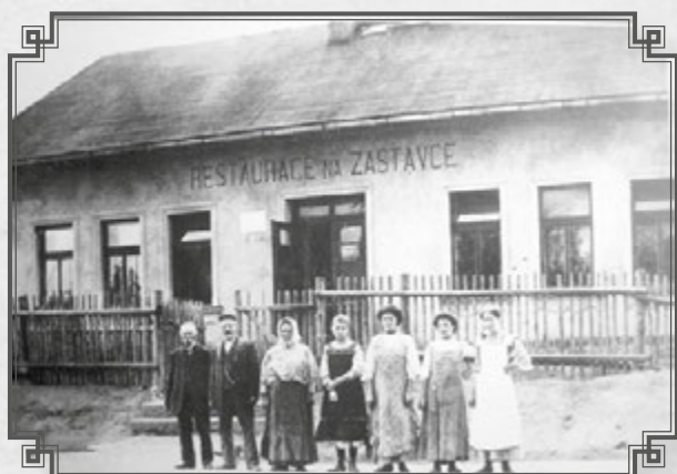
Restaurace Na Zastávce související s tratí Světlá – Kácov
