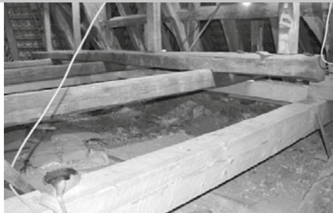
Konstrukce krovů nesoucí střechu kostela. V popředí osmimetrový vazný trám, již na svém místě
