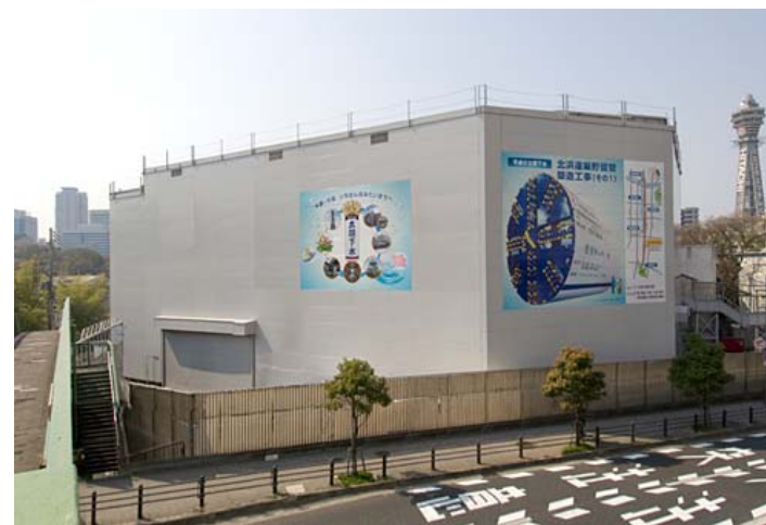
仮設防音設備イメージ
