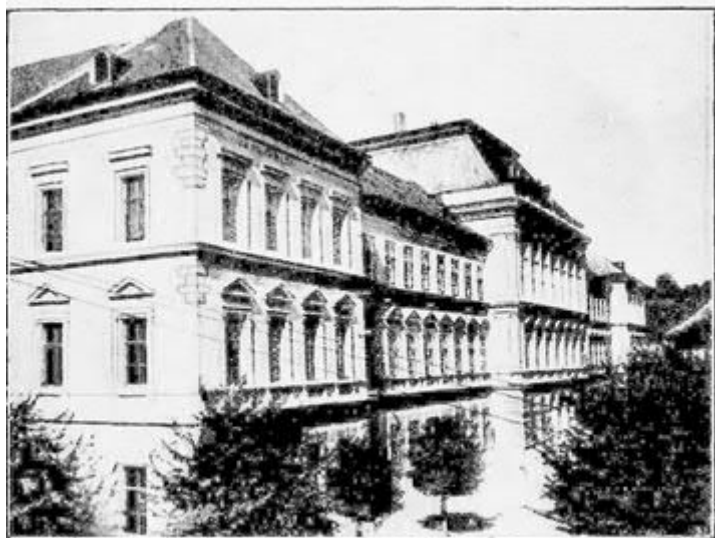
A ref. Kollégium homlokzata
