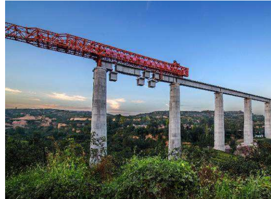
节段拼装施工方法
