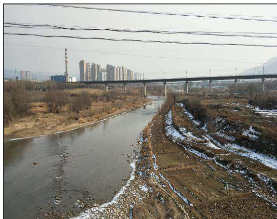
特大桥跨灞河桥址
