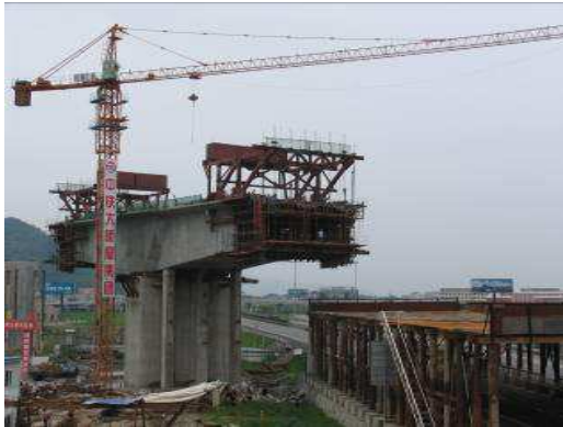
悬臂浇筑施工方法
