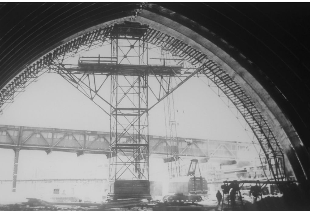
На фото: строительство склада крупнозернистого концентрата РУ-2
