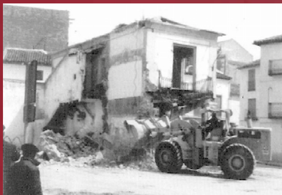
Demolición de los chiqueros y de los soportales de la plaza. Octubre de 1972
