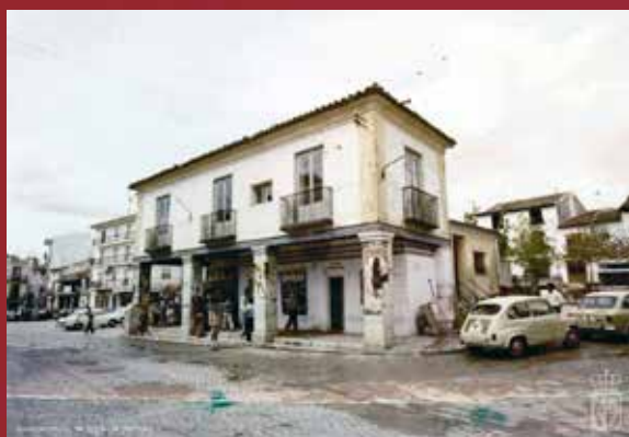
Soportales de la plaza un día antes de su demolición. Octubre de 1972
