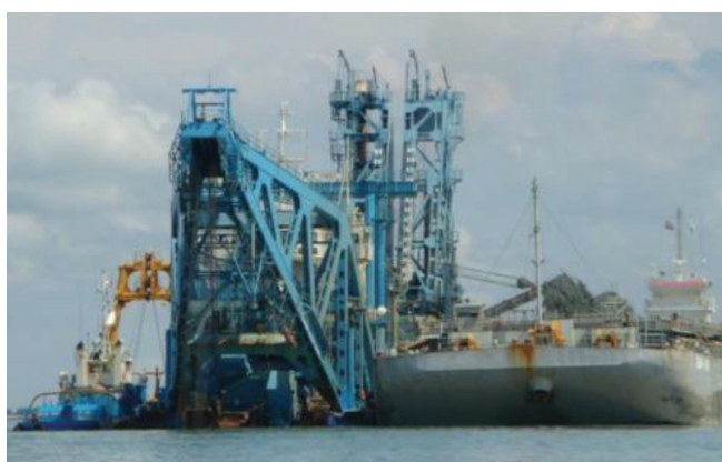
Cai-Mep Thi Vai Channel Dredging
