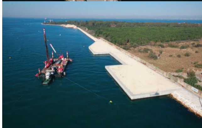
Venice: Bocca di Malamocco – Caissons precast plant
