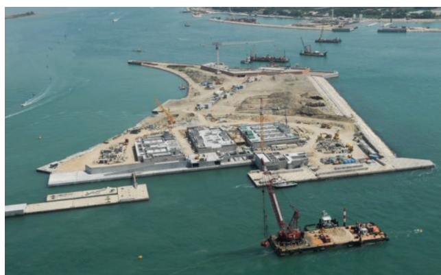
Venice: Bocca di Malamocco – Caissons precast plant
