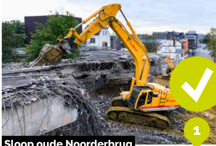
Sloop oude Noorderbrug
