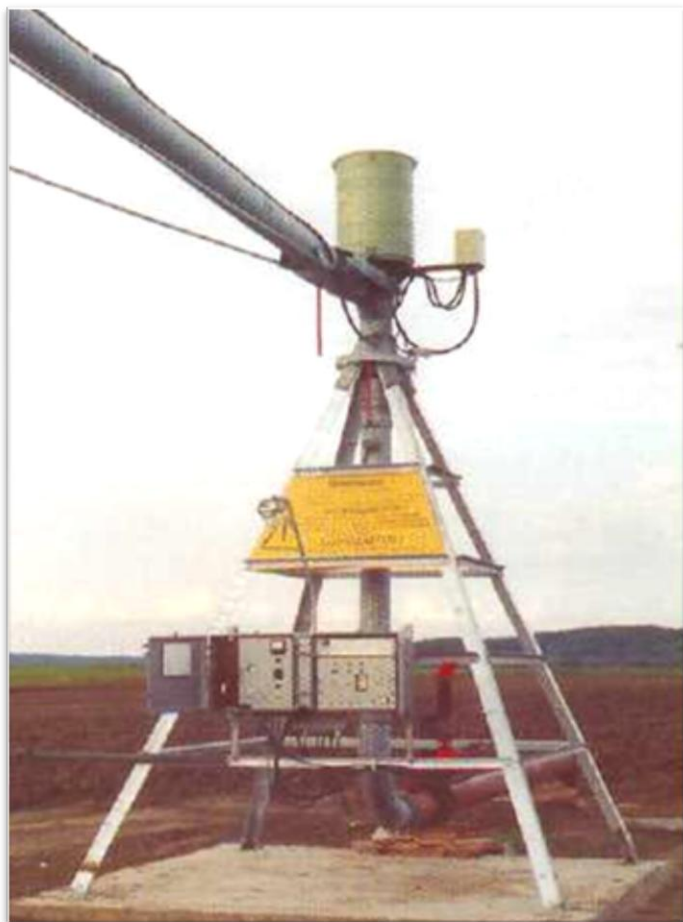
Рисунок 12 – Водозаборный узел дождевальной машины кругового действия "Кубань-ЛК1"
