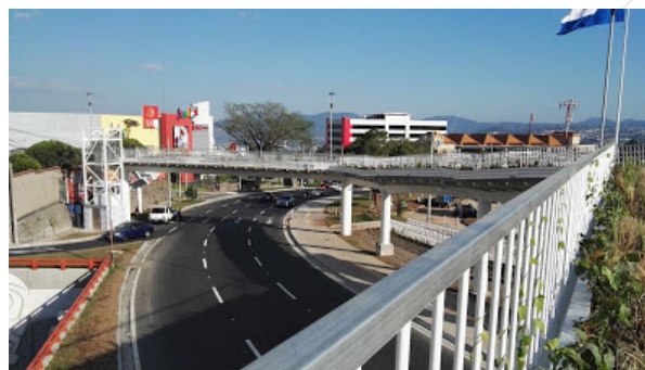
Pasarela del Redondel Masferrer, San Salvador.
