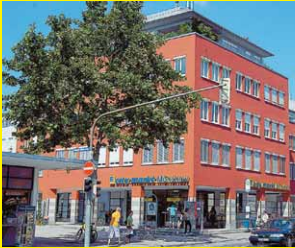
Seit dem Sommer leuchtet ein warmes Rot über den Heinrich-Weber-Platz und auch die zweigeschossige Tiefgarage der Stadtwerke unter dem Platz wurde saniert. Jetzt erstrahlt auch der Citymarket Münchow in neuem Glanz. swb-Bilder: of
