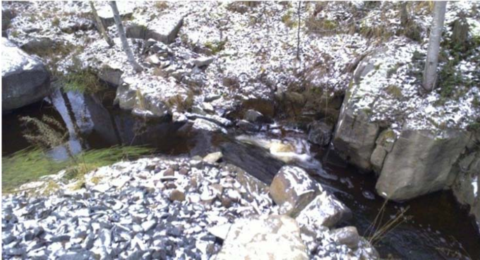
Kuva 7.18. Laskeutusaltaan veden purkupiste. Allas jää kuvassa vasemmalle. Altaan pinnankorotus onnistuu nostamalla purkukohtaa noin 30 cm ja rakentamisessa tarvittavaa kiviainesta on ympärillä jo valmiina. Kuva Kimmo Makkonen 29.11.2012
