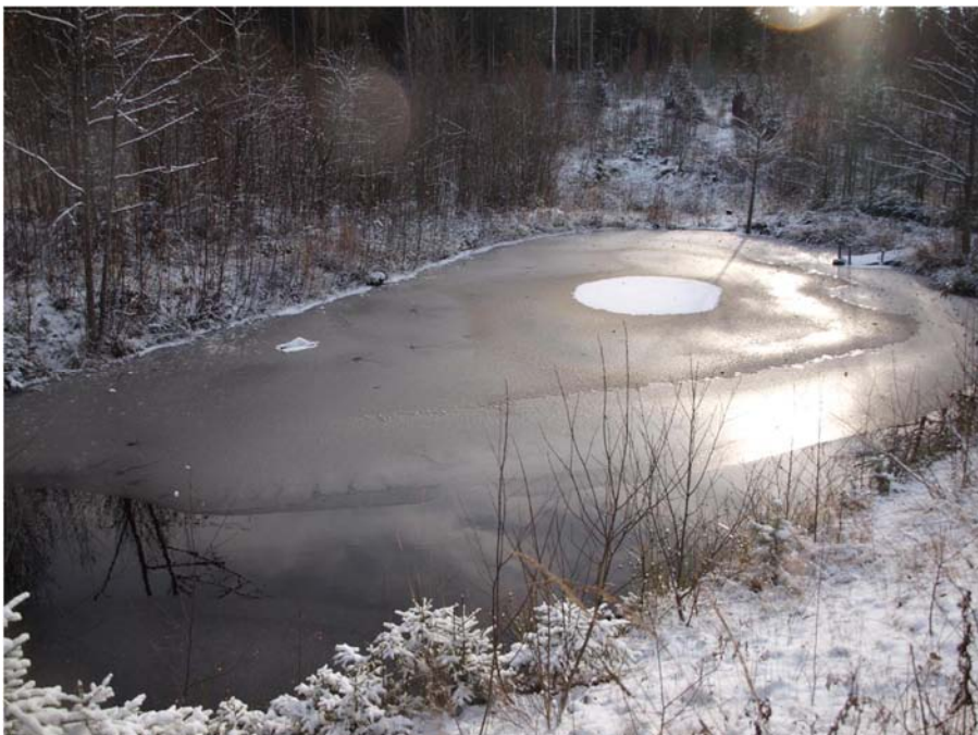
Kuva 7.17. Sinisillanojan allasketjun ylimmäinen laskeutusallas. Sinisillanoja kulkee kuvassa altaan vasenta laitaa penkereen takana noin viiden metrin päässä altaan reunasta. Välipenkereen purkamisella saataisiin laskeutusaltaaseen tilavuutta noin puolet lisää. Kuva Kimmo Makkonen 19.10.2012
