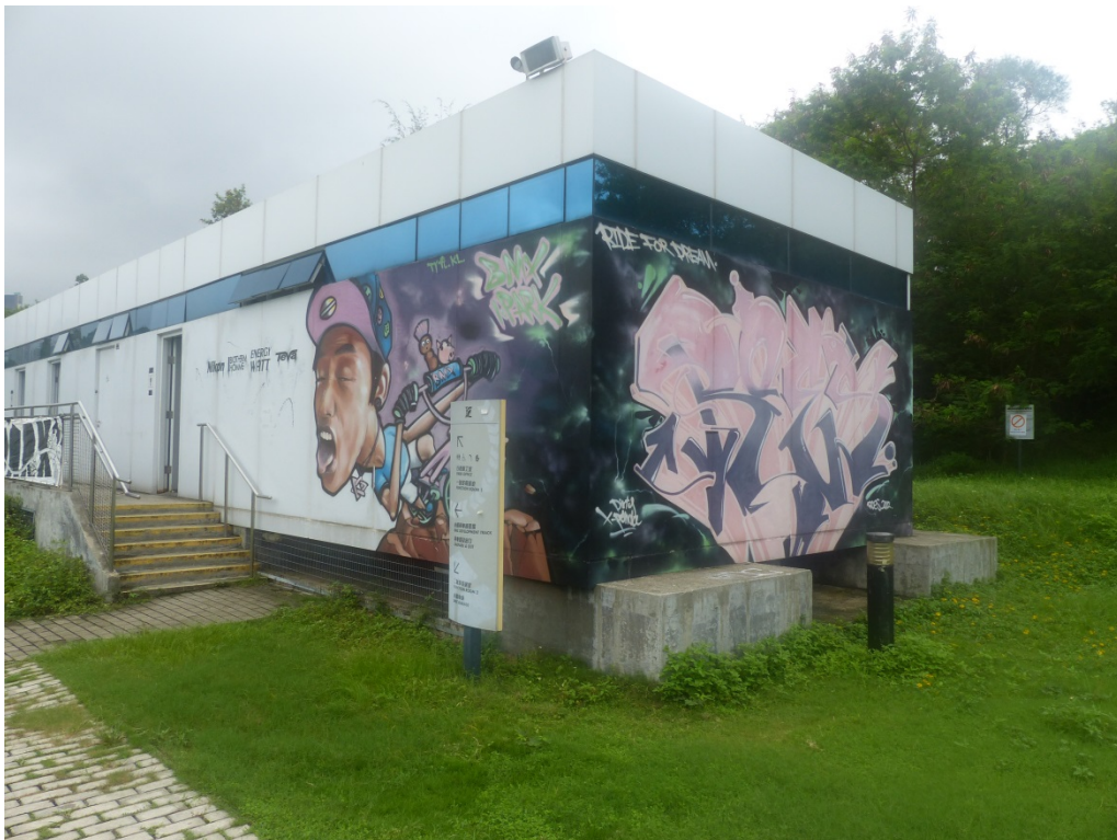
(2) 醉酒灣堆填區已架高的辦公大樓
