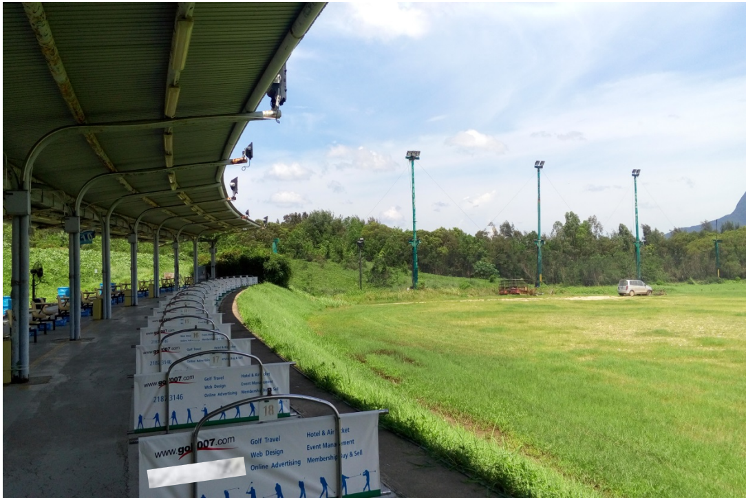
(9) 船灣堆填區的射燈裝置
