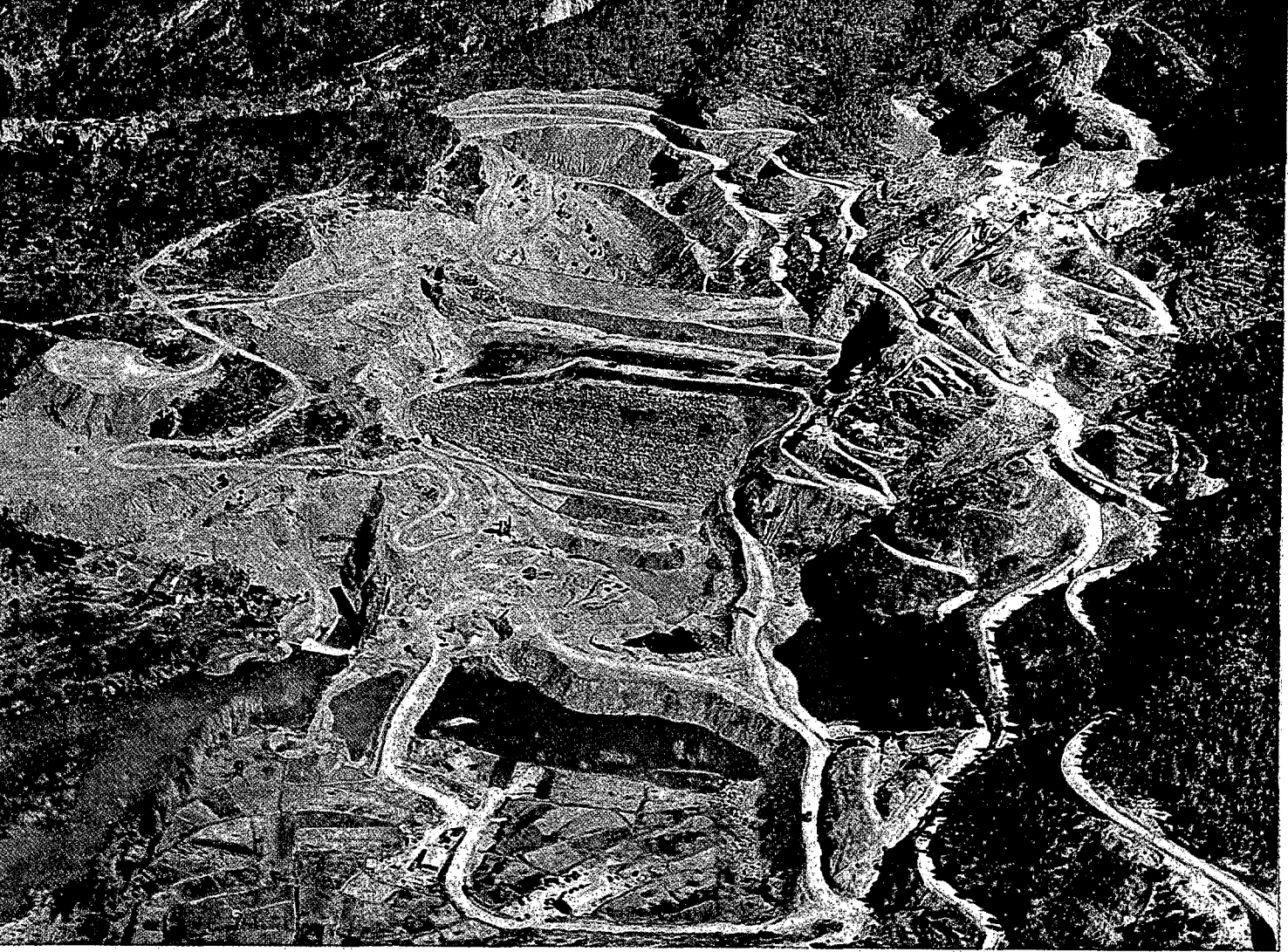
Fig. 2. — Vista general desde agua arriba.
