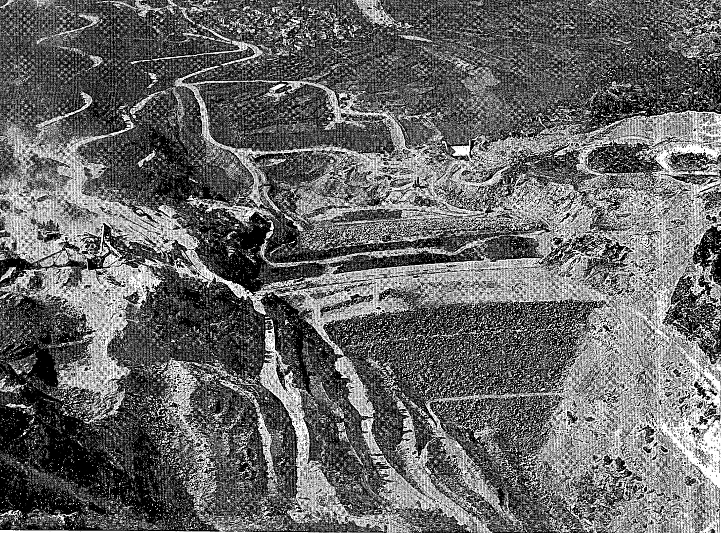
Fig. 4. — Vista general desde agua abajo.
