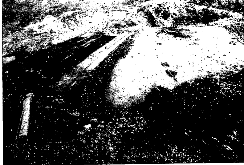
Fig. 9. — Ejecución de terraplenes y galería de drenaje.
