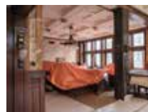
2015 Start verbouwing pand Industria
