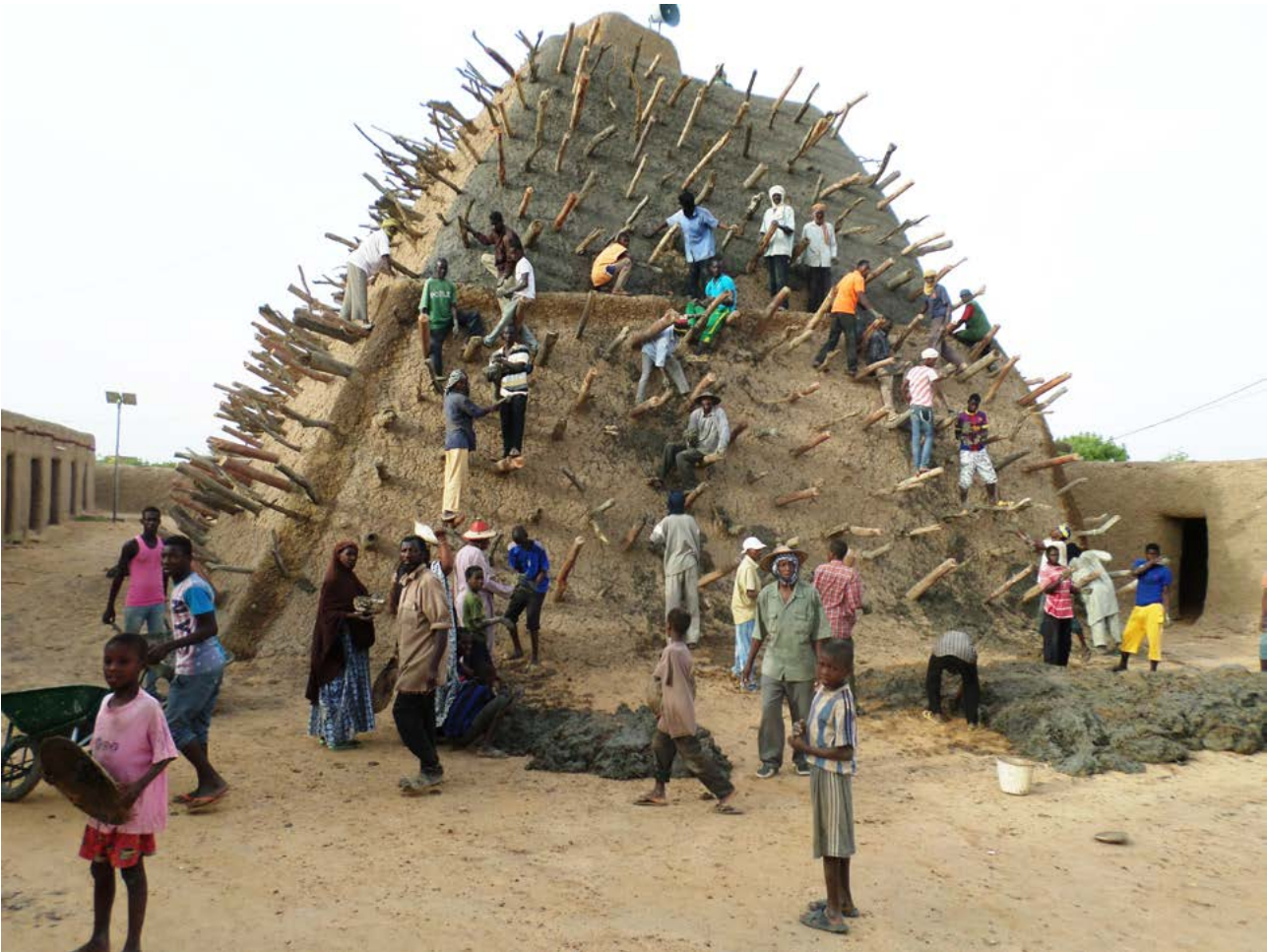
Premier crépissage post-crise, en 2014, de la tour pyramidale après le conflit armé de 2012 © A. Yattara
