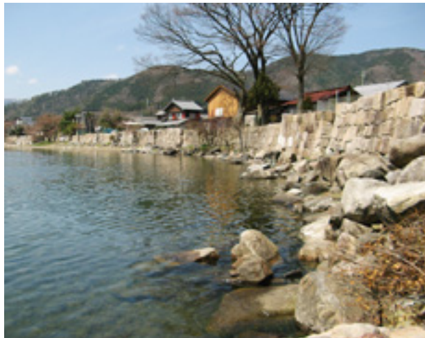
海津の湖岸には東浜、西浜合わせて1163mの波よけの石積みが築かれている
