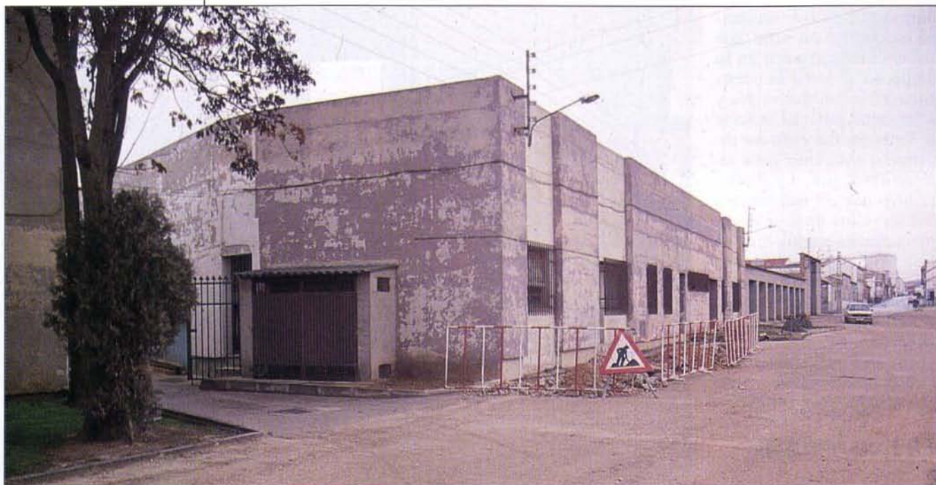
Los propietarios del Polideportivo "Los Molinos" cederán unos 8.000 metros cuadrados para la construcción del geriátrico.
