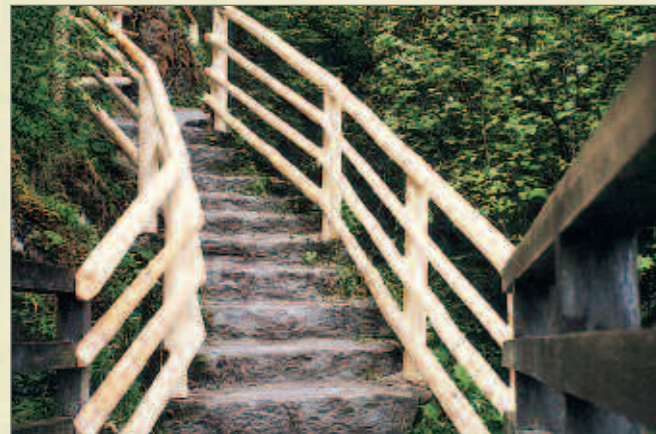
Neues Geländer beim "Jagasprung"
