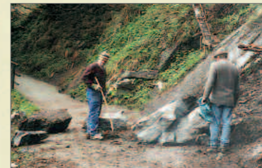
Beseitigung von Lawinenschäden sind im Frühling regelmäßig notwendig.
