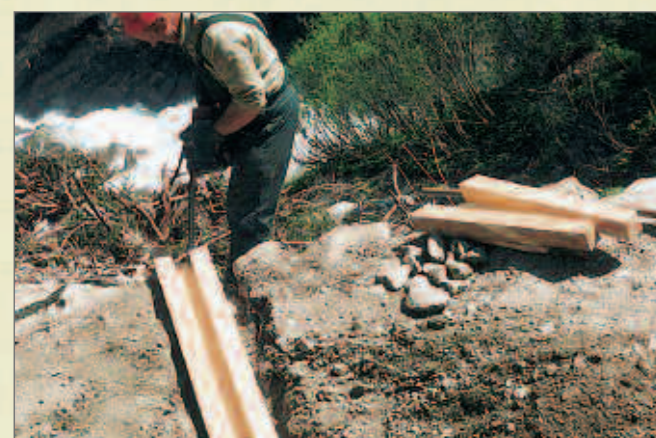
Einbau einer Wasserrinne
