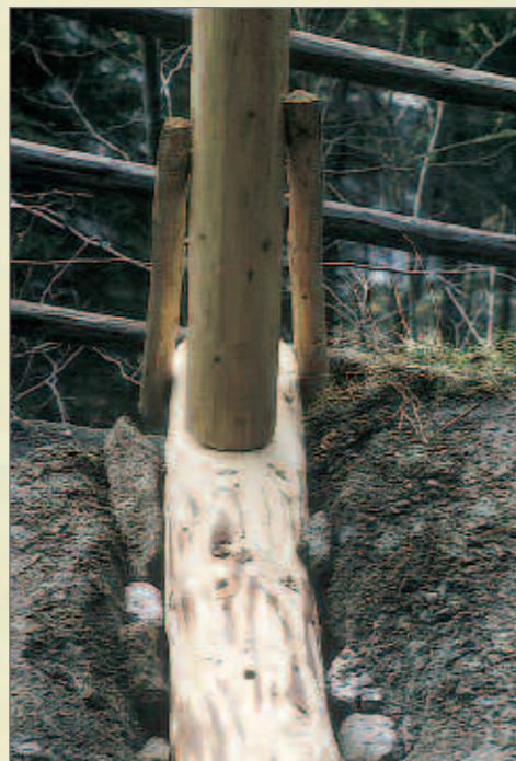
So wird ein Geländersteher eingebaut.
