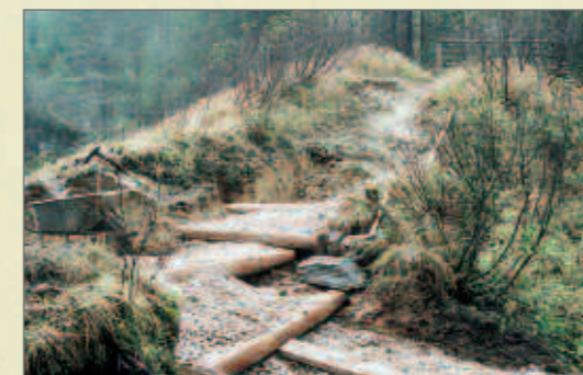
Entlang des Erosionsgrabens werden Holzbalken eingebaut.
