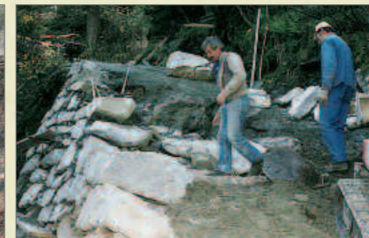
Baustelle bei der kleinen Wasserfallklamm - Okt. 1995
