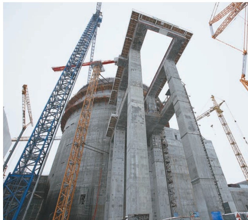
Сейчас в здании реактора энергоблока №2 Белорусской АЭС выполняются работы по устройству внутренней защитной оболочки выше отметки +44 – на его куполе
