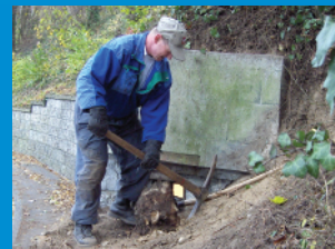
Freilegen des Lmg-Standes Rüdlinger Brücke 2007
