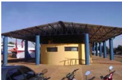
Construcción de la Terminal de Ómnibus
