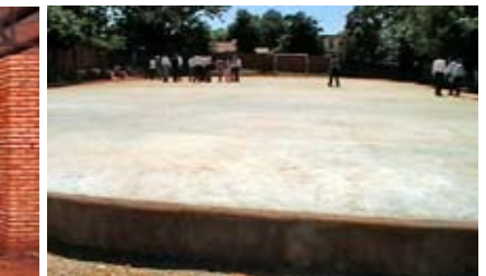
Construcción de pista deportiva en centro de educación
