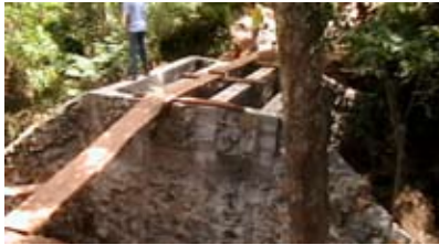
Construcción Puente Torín
