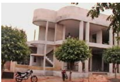
Construcción del Palacete Municipal
