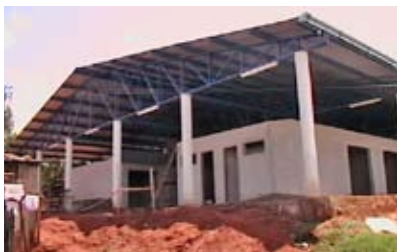
Construcción del Mercado de Abasto
