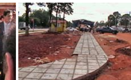
Construcción de vereda zona Terminal
