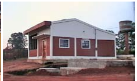
Construcción de la Matadería con su pileta de tratamiento
