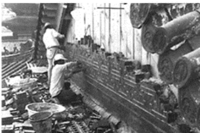
29) Bricking a gable.
