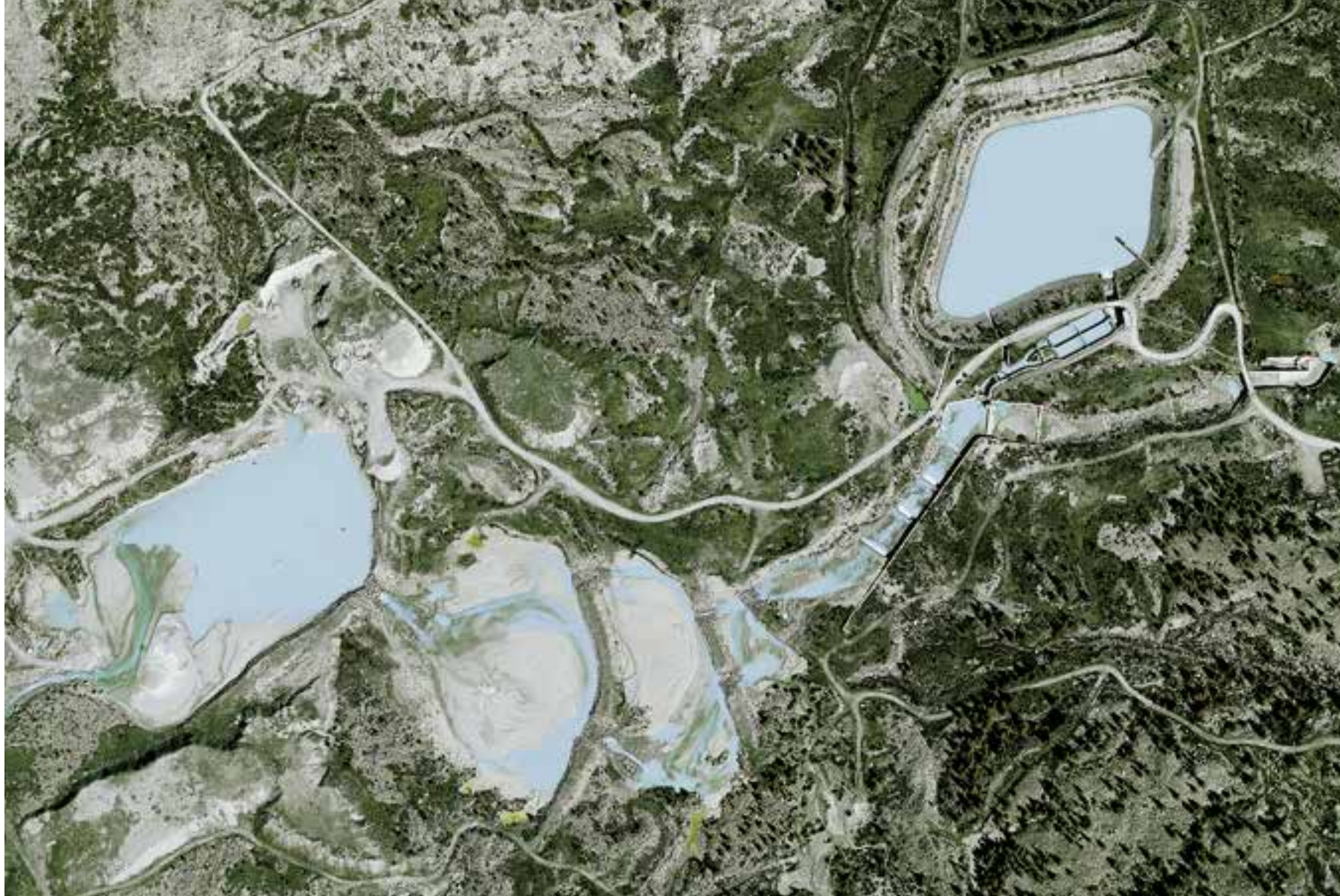
Pumpstation Stafel, ganz hinten im Mattertal
