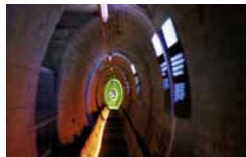
Führung im Innern der Staumauer
