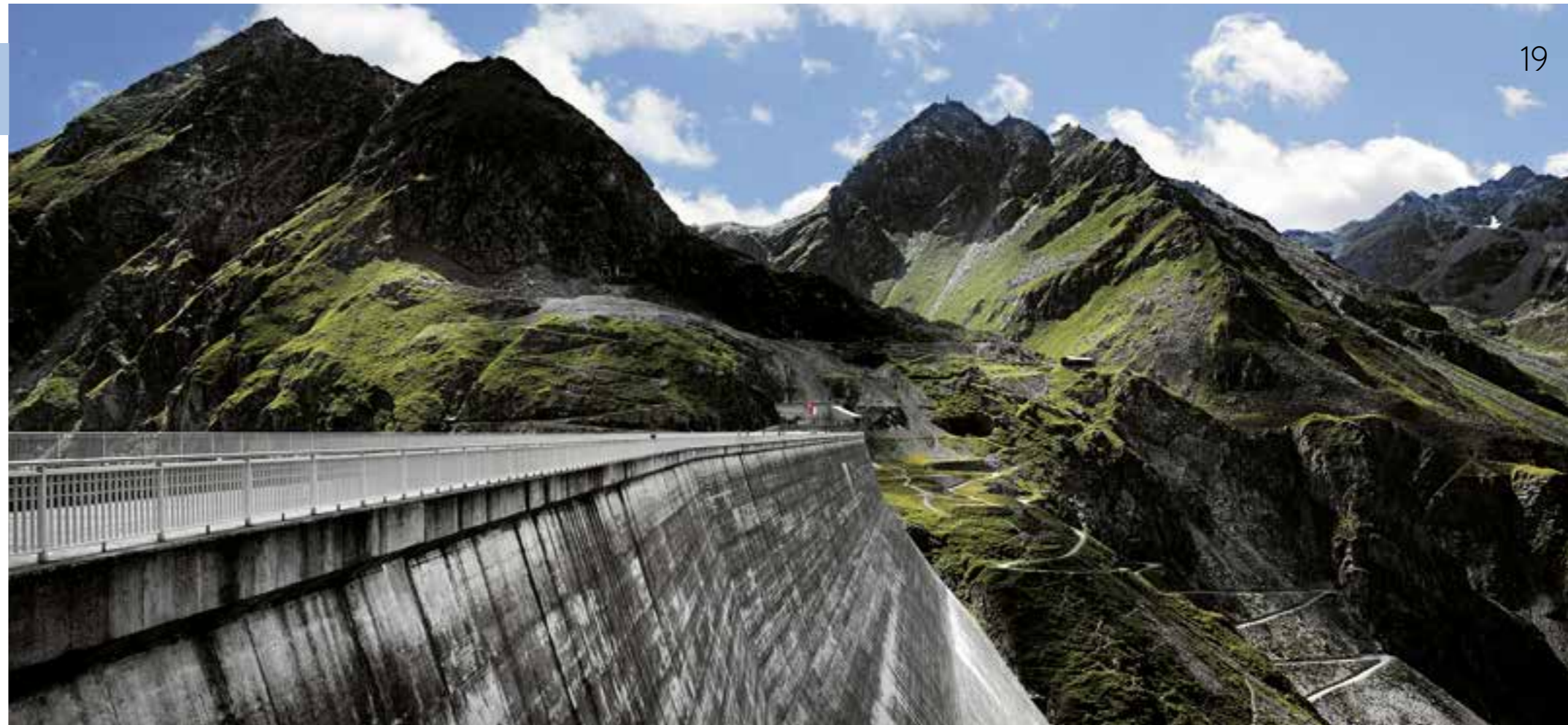
Begehung der Staumauerkrone
