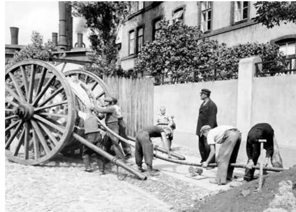
Rozwijanie kabla elektrycznego ze szpuli, Warszawa Unwinding of an electric cable from the reel, Warsaw.
