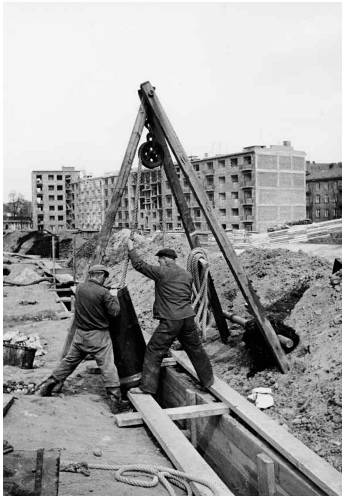
Roboty kanalizacyjne Sewage work in process.
