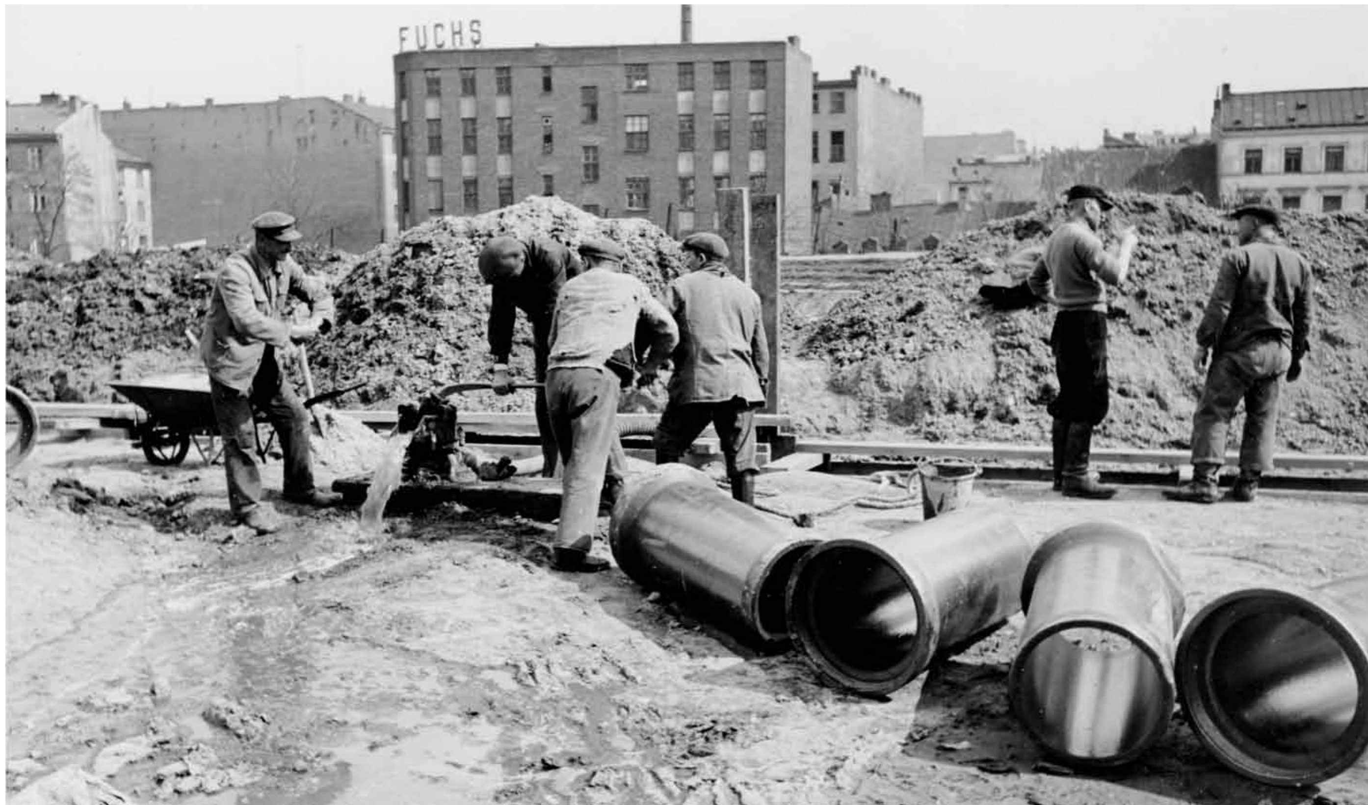
Roboty kanalizacyjne Sewage work in process.
