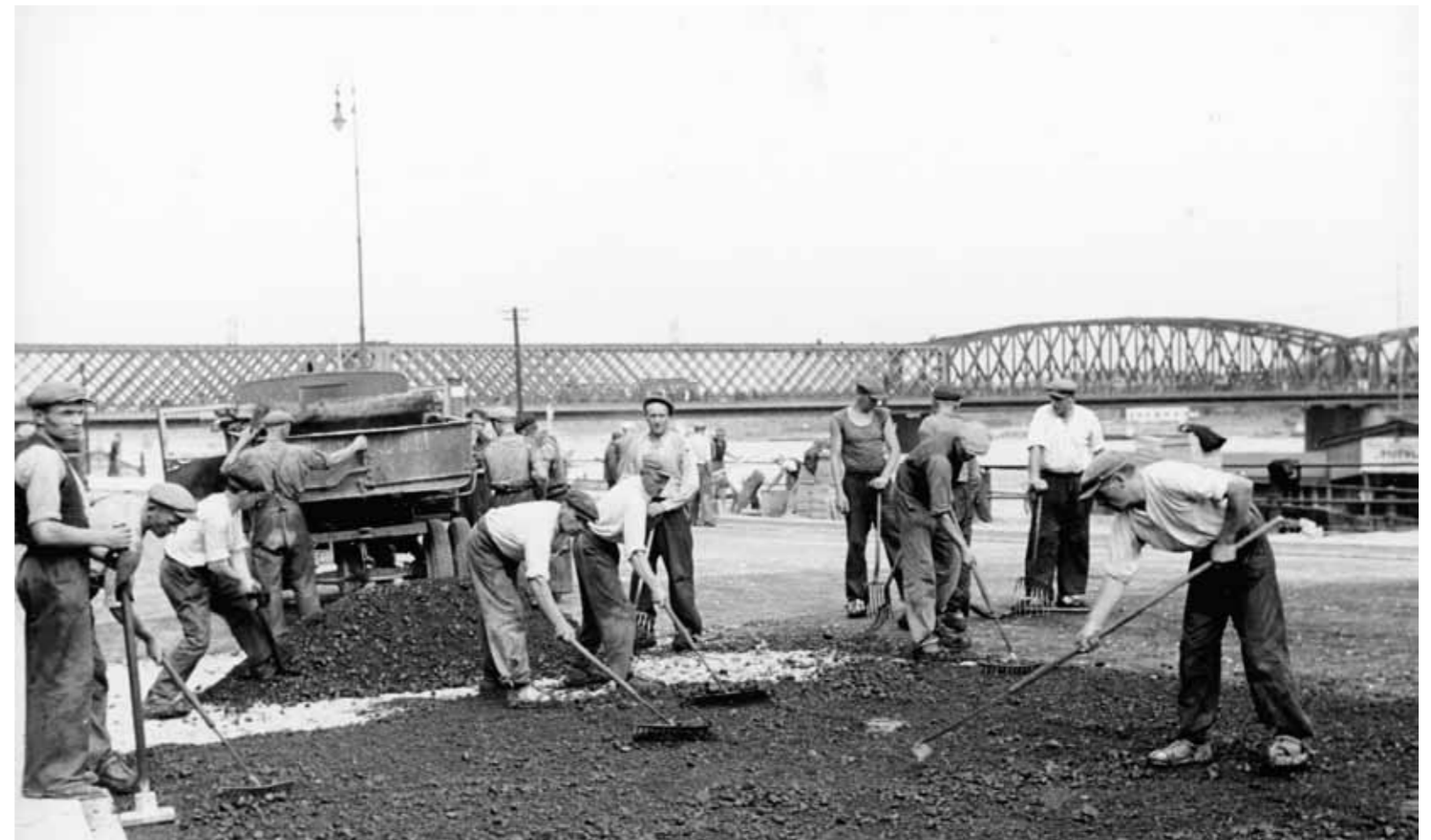
Rozgrabianie asfaltu na podkładzie, Warszawa Raking of asphalt on the base, Warsaw.
