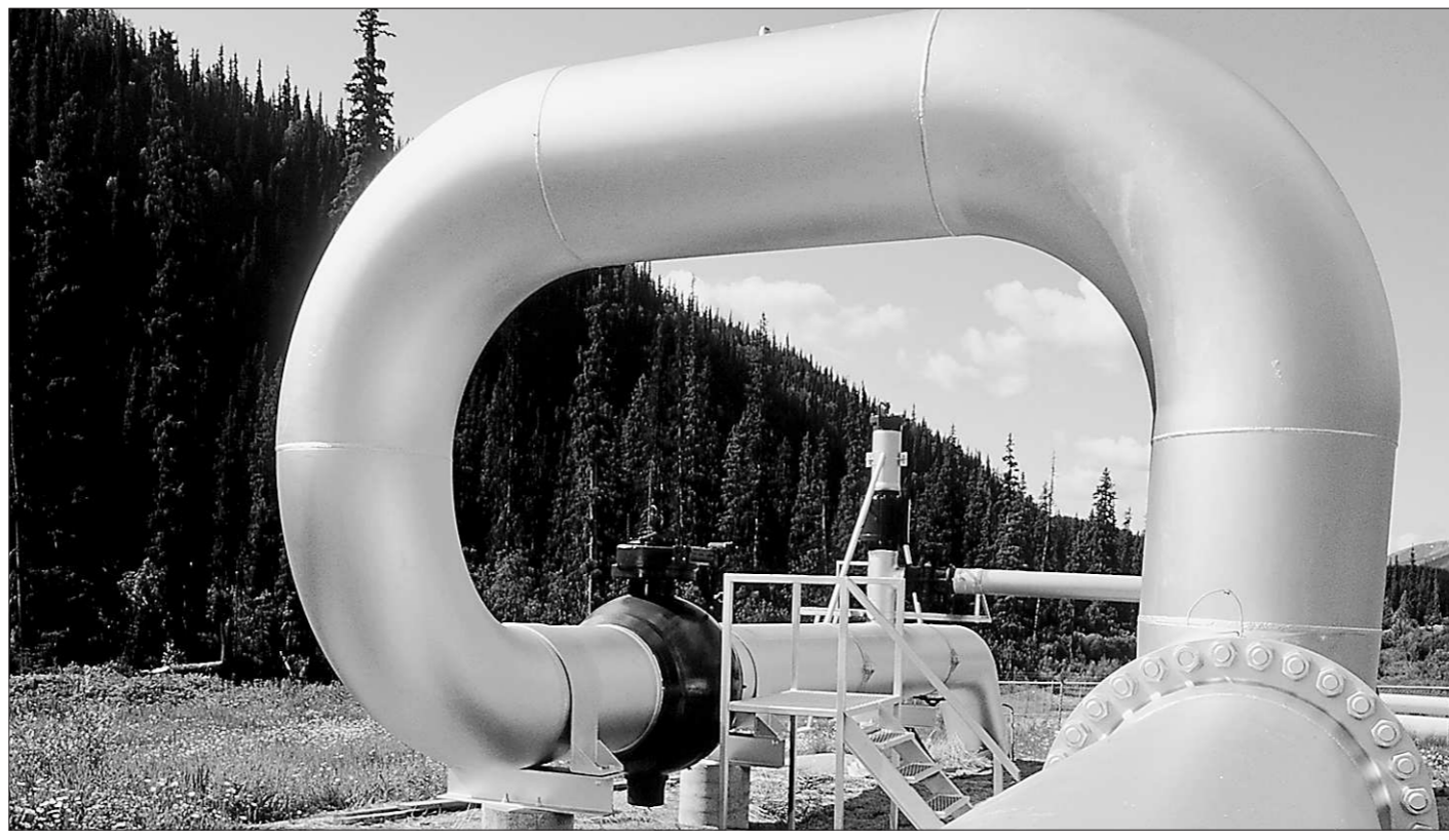
Вот такая загогулина – бесхозный газопровод...
