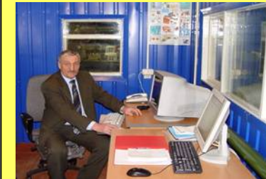
Пункт АСУ ТП ДЭС
