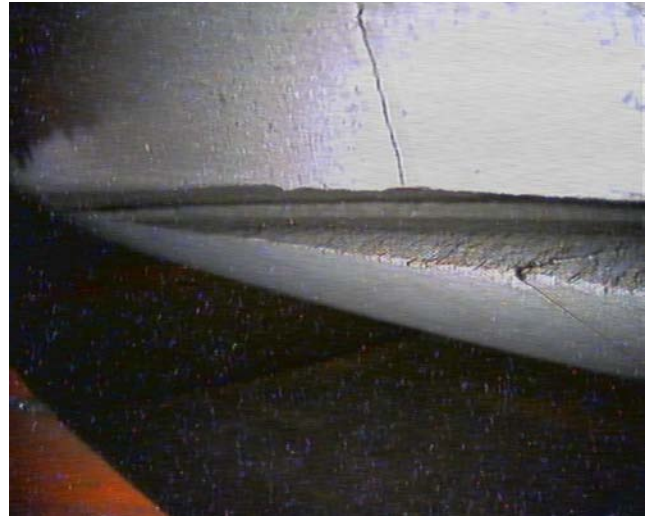
Рис. 8. Пропил в графитовом блоке, вид с робота-углореза
