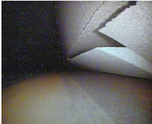
Рис. 9. Срезанные углы графитовых блоков перед падением
