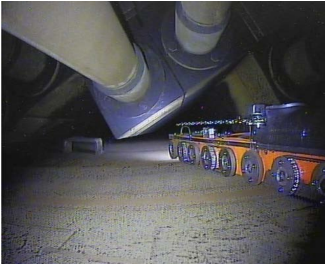
Рис. 7. Робот-углорез перед спуском в зазор КЖ-ГК, вид сверху с робота сопровождения.
