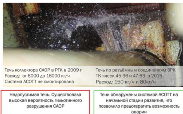
Рис 2. Течи на энергоблоке №4 Ленинградской АЭС [53]
