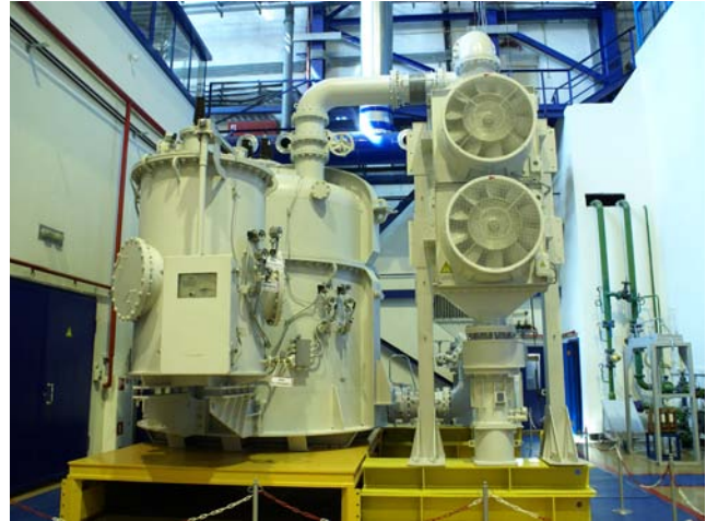
Рис. 5. ОРЭНДЦН-21000/220-У1 – с системой охлаждения «элегаз-воздух»
