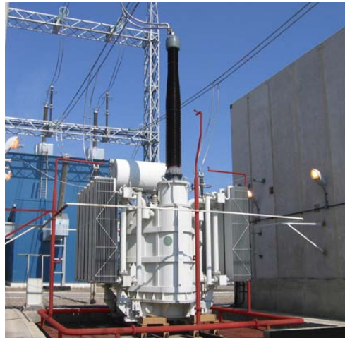
Рис. 3. Шунтирующий реактор РОМБС-60000/500
