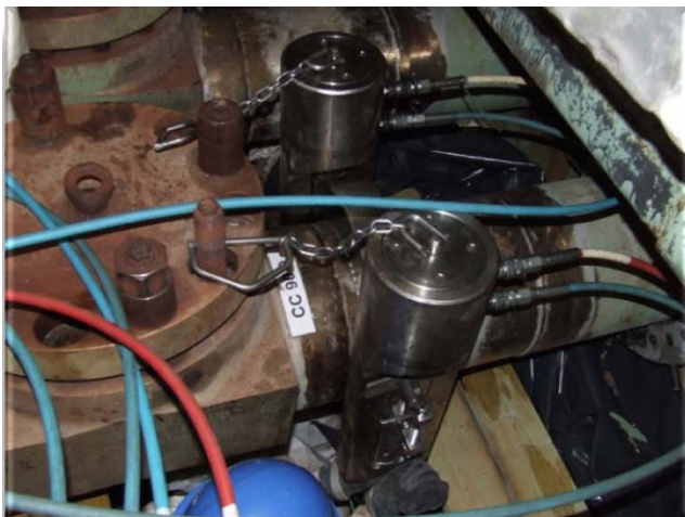
Рис. 1. Изображение установки обжатия, расположенной на трубопроводе в помещении энергоблока АЭС, при применении технологии MSIP
