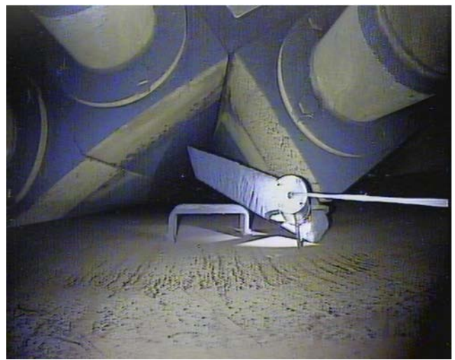
Рис. 10. Извлечение срезанного угла графитового блока из зазора КЖ-ГК
