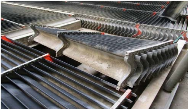
Рис. 11. Внешний вид каплеуловителя из центральной зоны БИГ энергоблока № 1 Новovoroneжской АЭС-2 (осмотр в ППР-2017)
