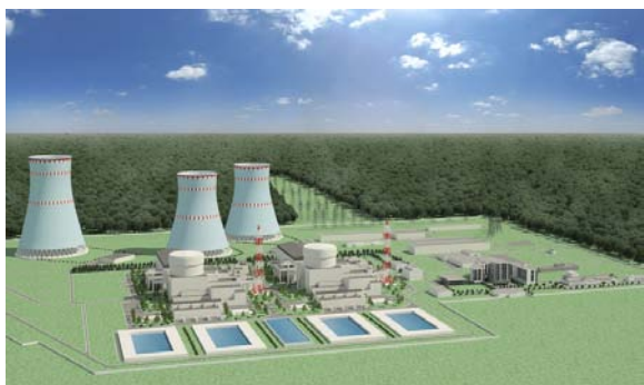
Рис. 4. Общий вид Ленинградской АЭС-2
