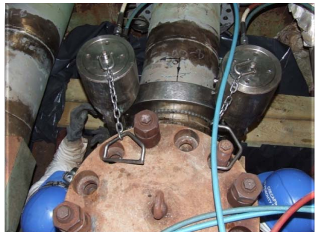
Рис. 1. Изображение установки обжатия, расположенной на трубопроводе в помещении энергоблока АЭС, при применении технологии MSIP
