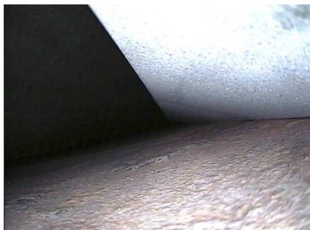
Рис. 2. Контакт между кожухом и графитовой колонной. Ку-АЭС, блок 2, ячейка 2762, высотная отметка 7,1 м, 11.06.2017
