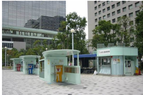
事例IV-7 駅前広場に機械式地下駐輪場を整備した事例
