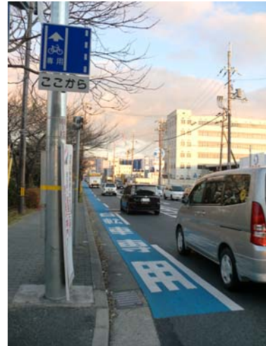
写真Ⅱ-7 道路標識「普通自転車専用通行帯(327の4の2)」と道路標示「専用通行帯(109の6)」を設置した事例
