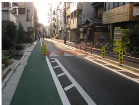
写真Ⅱ-12 車道部分にハンプを設置しハンプの両側にゴム製ポールを設置した事例
