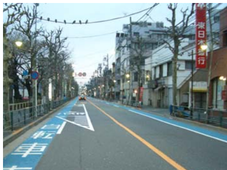
写真Ⅱ-15 バス停を示す路面表示を設置した事例
