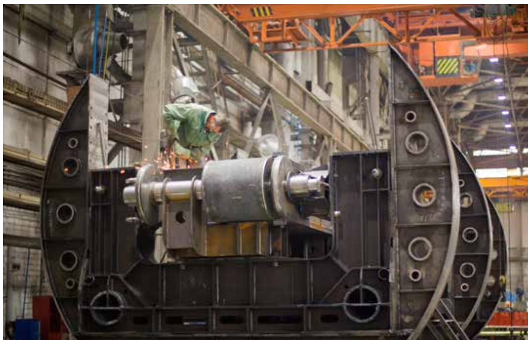
Сборка-сварка балок аутригеров для подъемного устройства
