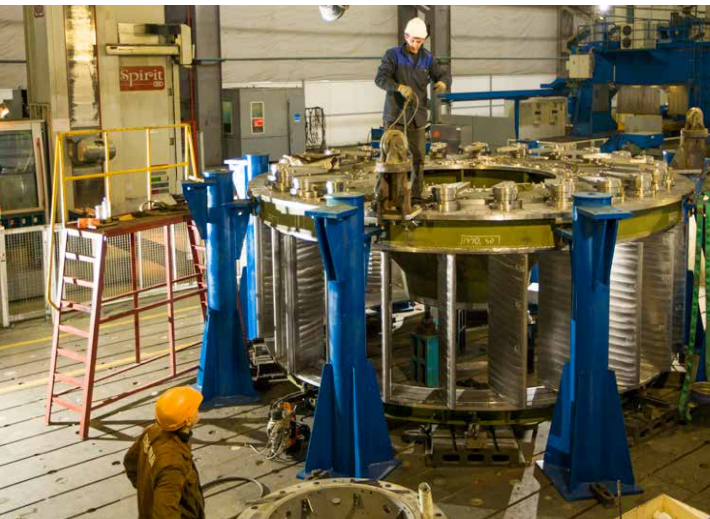
Контрольная сборка направляющего аппарата для Белопорожской ГЭС
