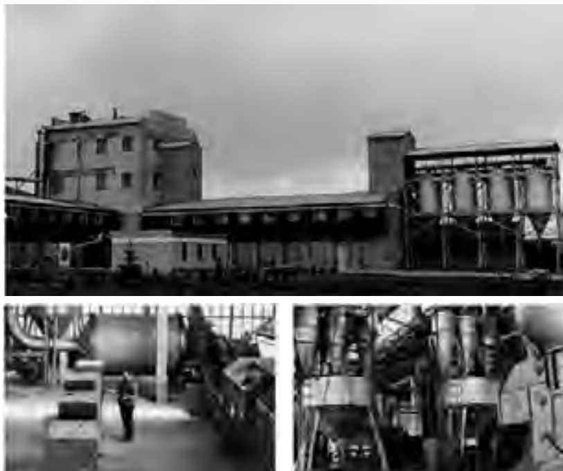
Рис. 17. Межколхозный комбикормовый завод производительностью 240 т в сутки, Предгорный район, Ставропольский край, 1982 г.
