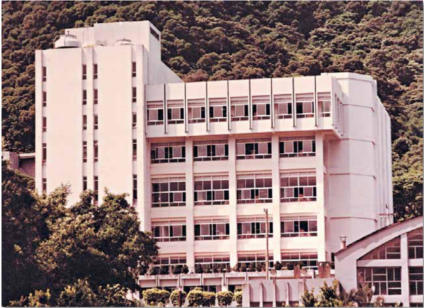
圖十一：為國內第一所具備中央空調設備的大學圖書館。
