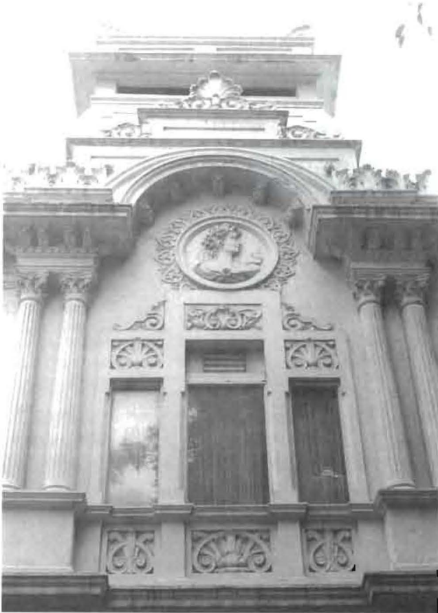
Detalle de un torreón del Palacio de Correos y Telégrafos, donde se destacan las decoraciones modernistas. Fotografía de Luis Fernando González E., 1994.
