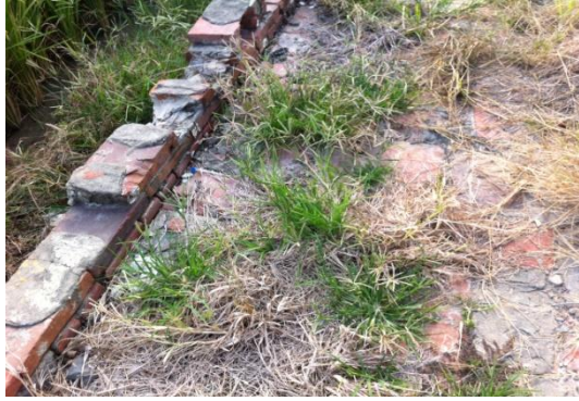
郭積慶公館外的圍牆遺跡
