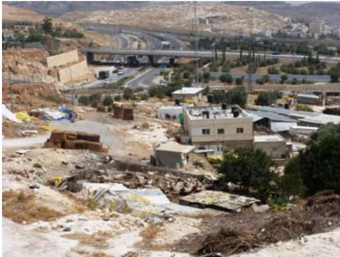
الجهة الشرقية - سكن للبدو وحظائر للمواشي
