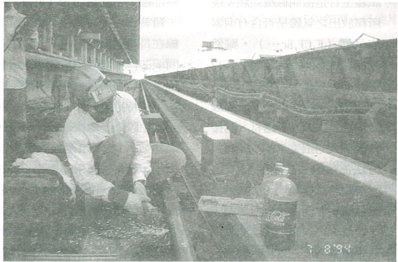
焊接點的軌道研磨
