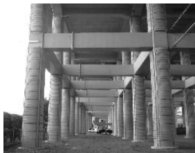
高架橋柱の耐震補強
