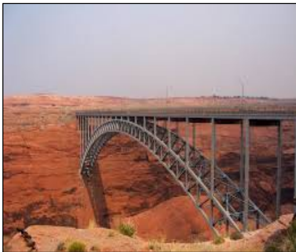
Glen Kanyon Köprüsü (Arizona)
