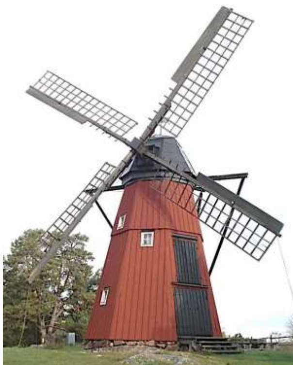
Bilden till höger togs 2014-01-15. Dåvarande kvarnvingar, från 1990-talet, höll 16 meter i diameter. Foto Per-Inge Gyllenhammar
