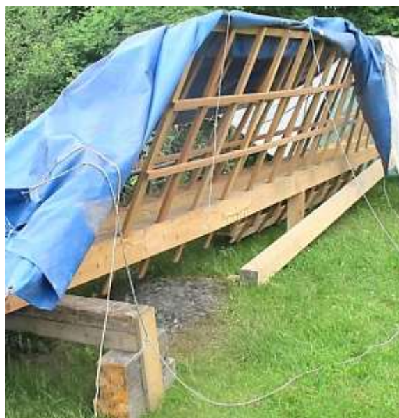
Kvarnvingar med häckverk/sprygelverk av finsågade bräder levererades 2015-06-29. Foto Hedvig Bellberg
