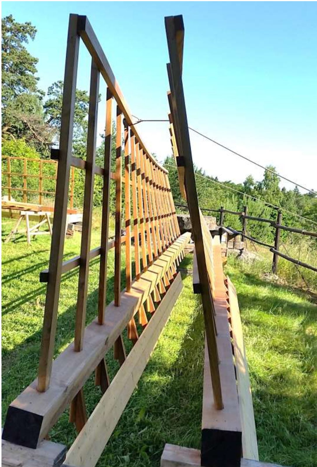
Inför impregneringen ställdes kvarnvingarna upp på bockar. På bilden ovan syns häckverket med spryglarna särskilt tydligt. Foto Per-Inge Gyllenhammar
