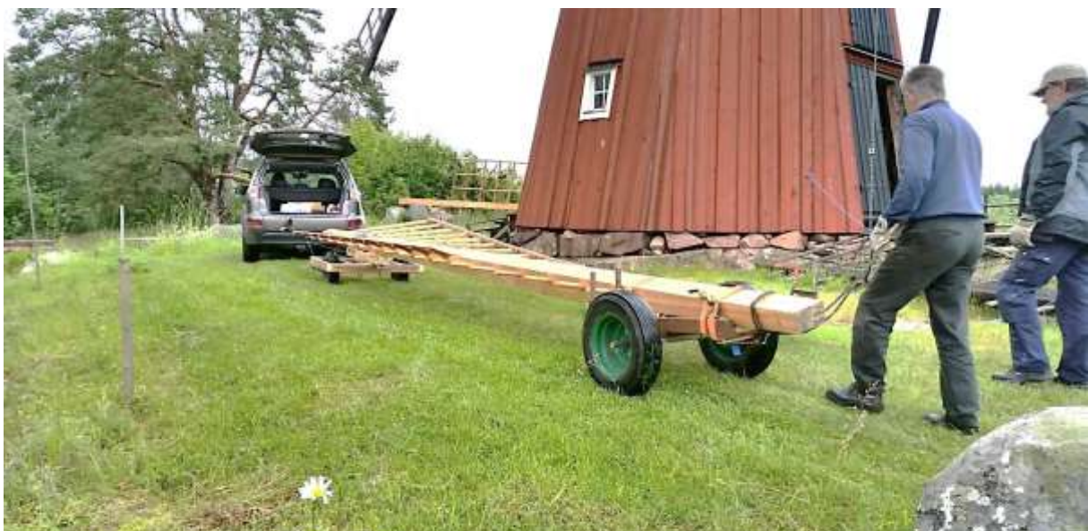
Slutsträckan fram till kvarnen kördes vingarna styckevis, på ett specialbyggt släp. Foto Per-Inge Gyllenhammar
