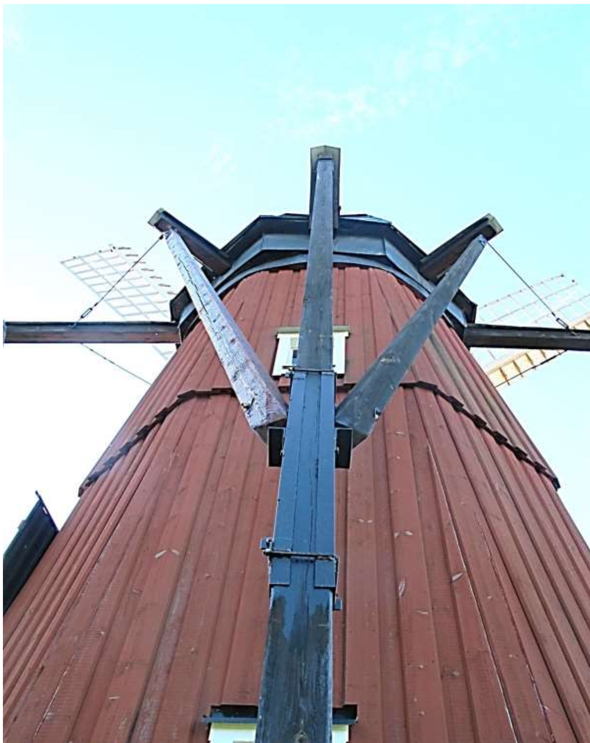
På kvarnhusets baksida sitter ett stort stag som tjärströks. Foto Hedvig Bellberg LP_2016_00112.
