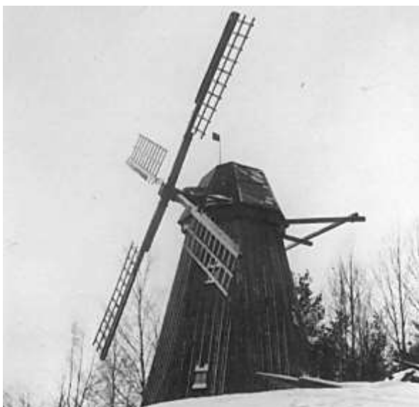
Överby kvarns södra sida, fotograferad vintern 1968, efter nyligen genomförda reparationer.
