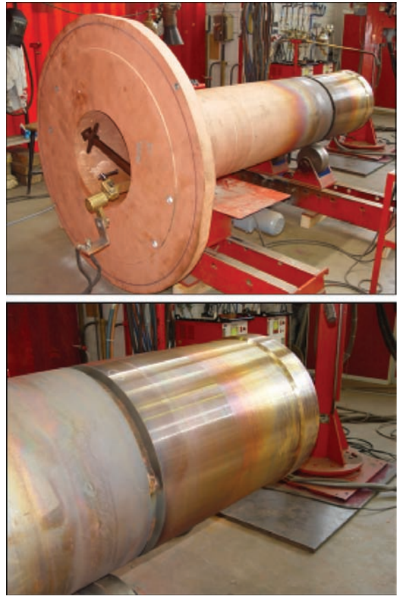
Рис. 15. Ремонт кокилей путем увеличения корпуса (удлинения)
