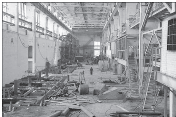
Рис. 10. Фрагмент строительства сортового отделения ЭШП-1 СПЦ-5
