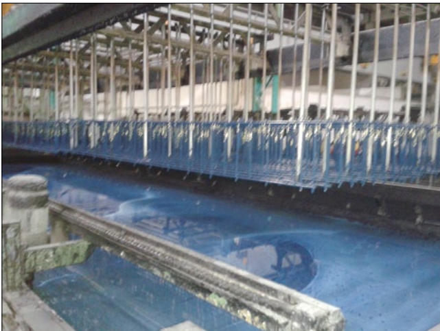
Рис. 3. Антикоррозионное покрытие пакета арматурных каркасов
