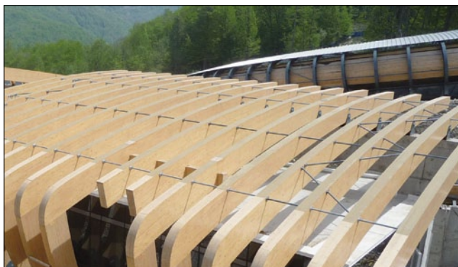
Рис. 7. Строительство санно-бобслейной трассы в г. Сочи. Верхние грани несущих КДК каркаса навеса защищены герметиком Акцент 125
