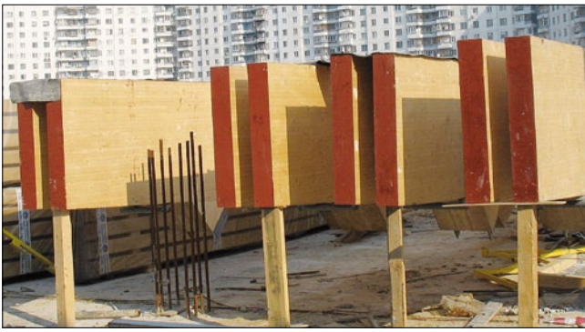
Рис. 4. Торцы элементов несущих КДК, защищенные эпоксидной шпатлевкой ЭП-0010 (физкультурно-спортивный центр «Строгино», Москва)
