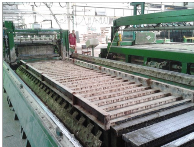
Рис. 6. Установка автоклавной решетки в стол резательной машины
