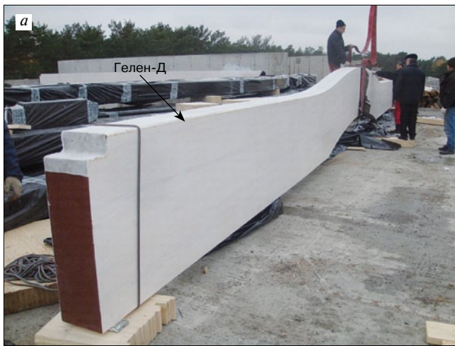
Рис. 8. Защита верхних граней несущих клееных деревянных балок покрытия самоклеящейся лентой Герлен-Д: а – бассейн в Барвихе; б – многофункциональный комплекс семейного отдыха и реабилитации здоровья в Москве
