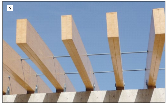
Рис. 4. Торцы элементов несущих КДК, защищенные эпоксидной шпатлевкой ЭП-0010 (физкультурно-спортивный центр «Строгино», Москва)
