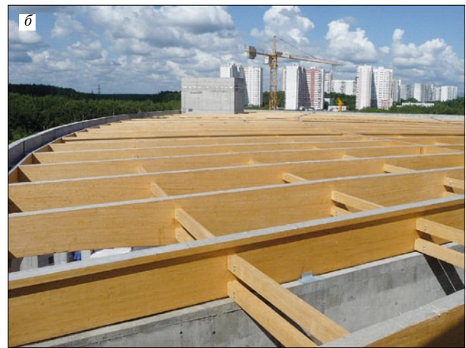
Рис. 8. Защита верхних граней несущих клееных деревянных балок покрытия самоклеящейся лентой Герлен-Д: а – бассейн в Барвихе; б – многофункциональный комплекс семейного отдыха и реабилитации здоровья в Москве
