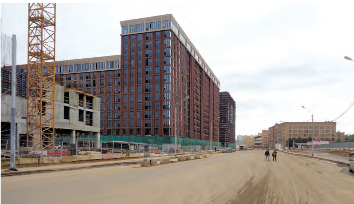
▲ Дорога от четвертой проходной к переходу в АСК
