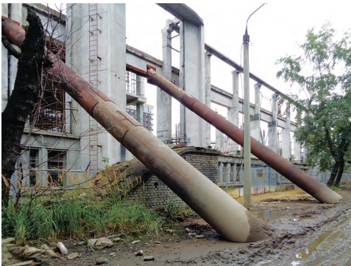
▲ Фасад бывшего Прессового корпуса
