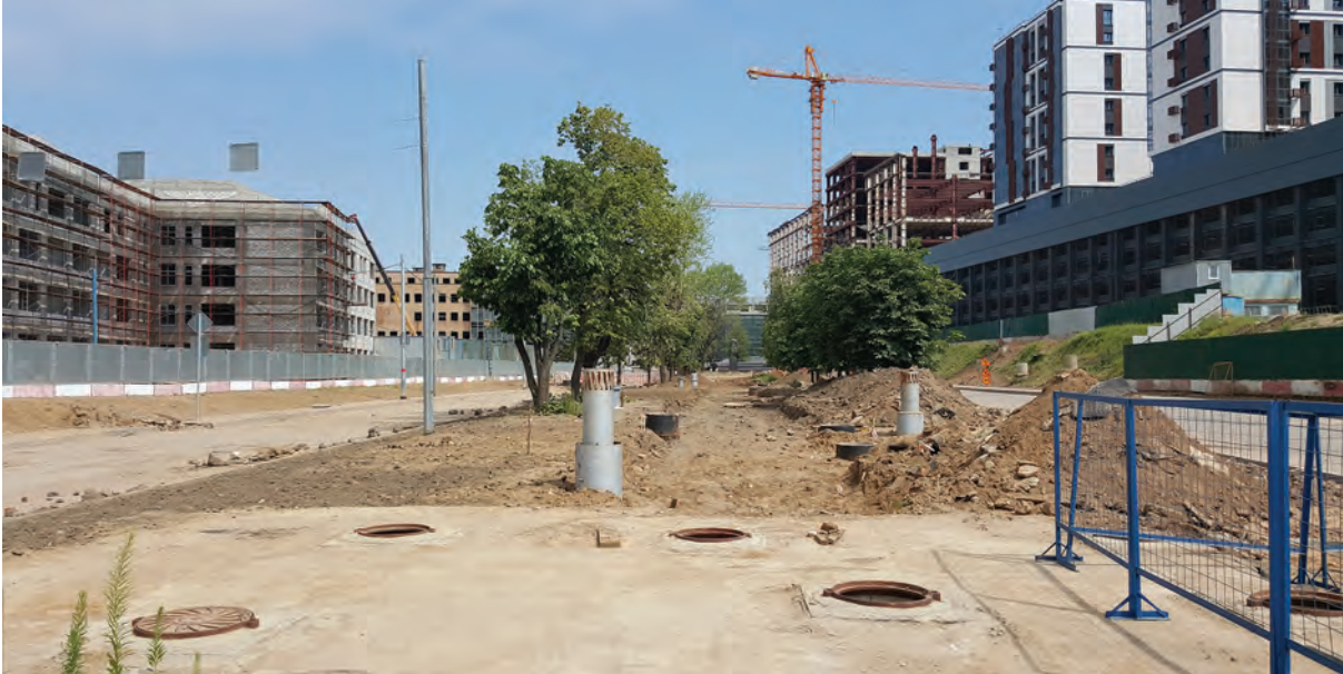
▲ Зиловский бульвар. Южная часть: в месте пересечения с проспектом Лихачёва. Справа – Новый кузовной корпус, слева – строящаяся школа
