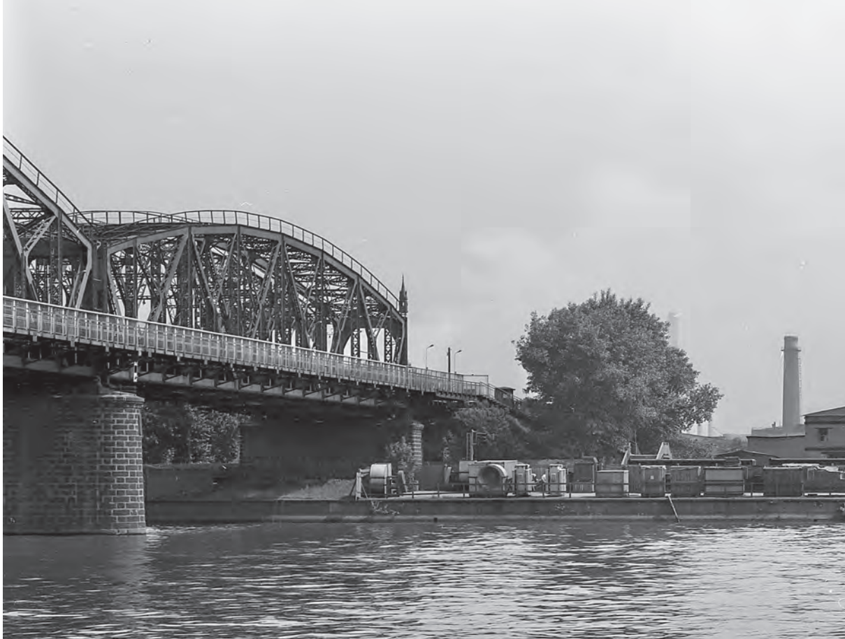
▲ Мост МКЖД, с восточной стороны которого находилась шестая проходная завода
