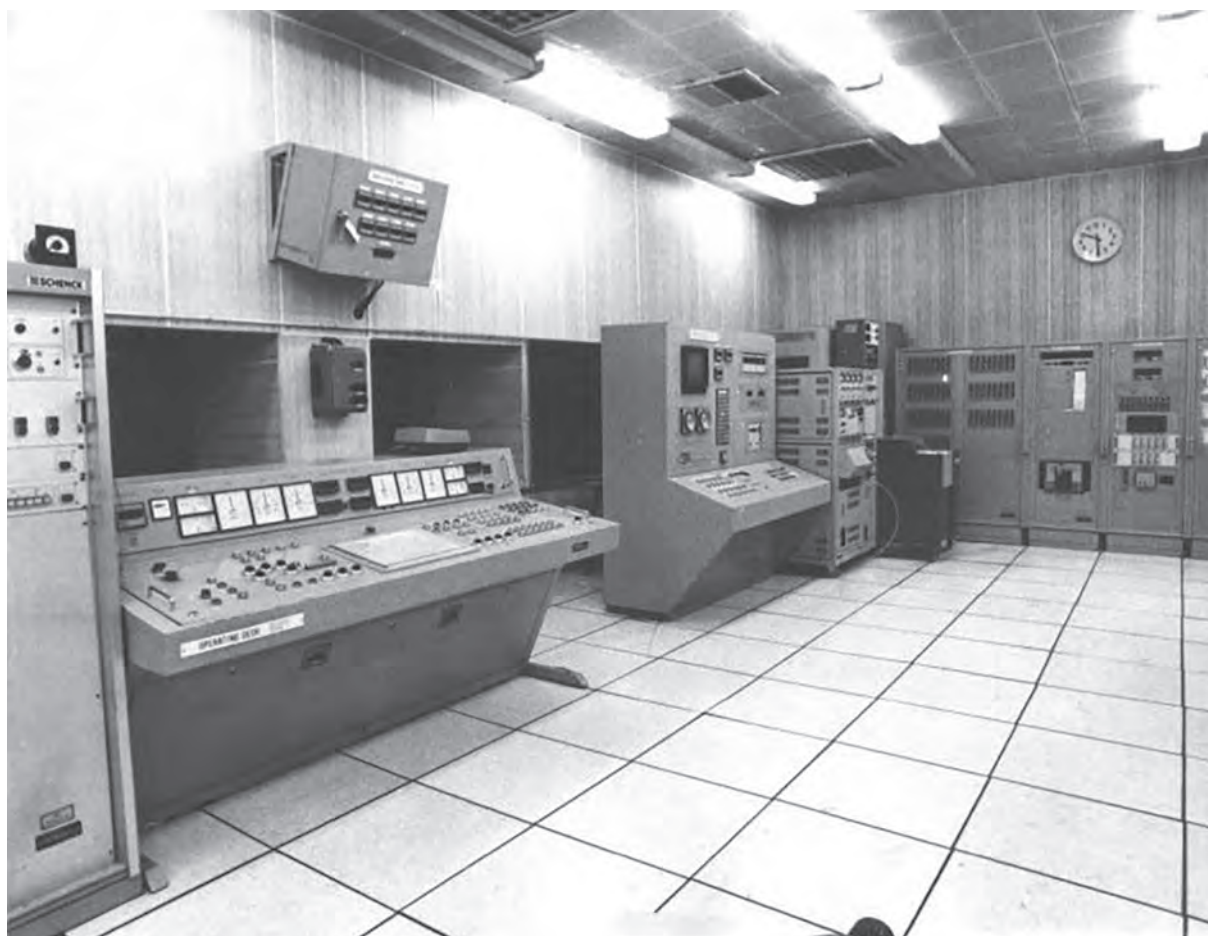
▲ Пульт управления Аэроклиматическим комплексом
