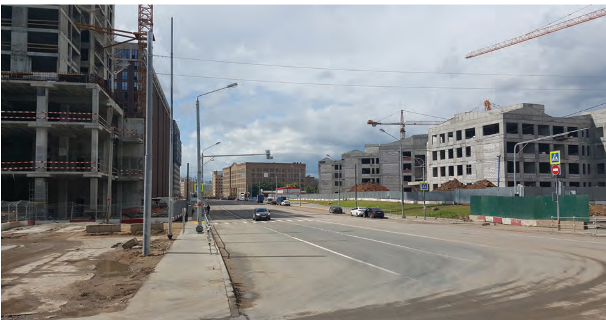
▲ Проспект Лихачёва. Западная часть: в месте пересечения с Зиловским бульваром. Справа – строящаяся школа, за ней вдали – Инженерный корпус
