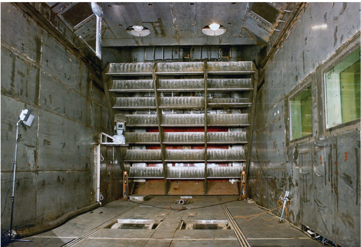
▲ Вид на направляющий аппарат холодильной камеры
