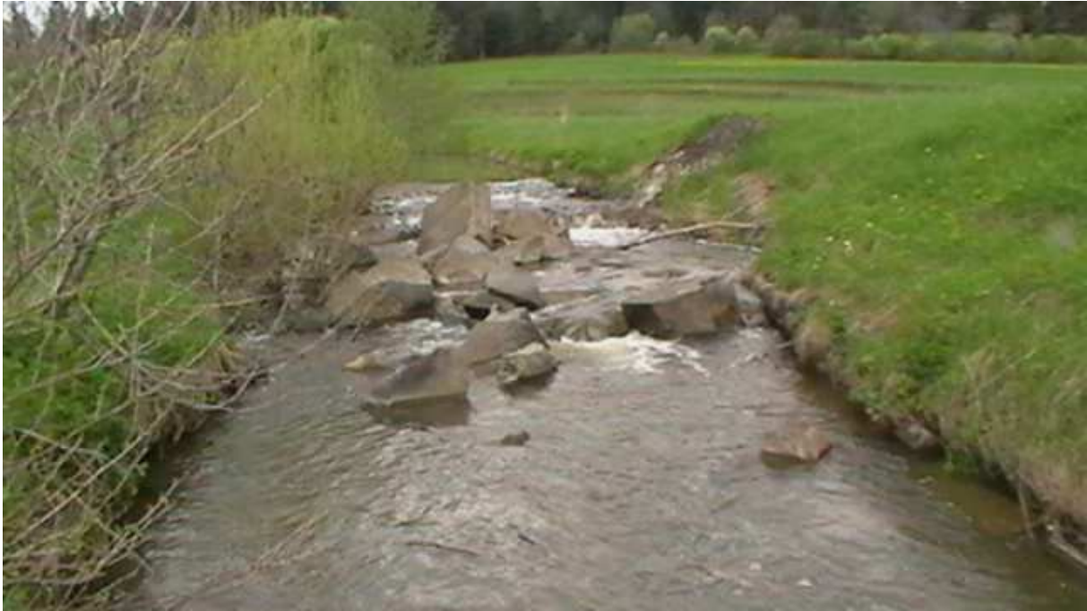
Fot. 13. Pozostałości stopnia na potoku Bębeńskim
