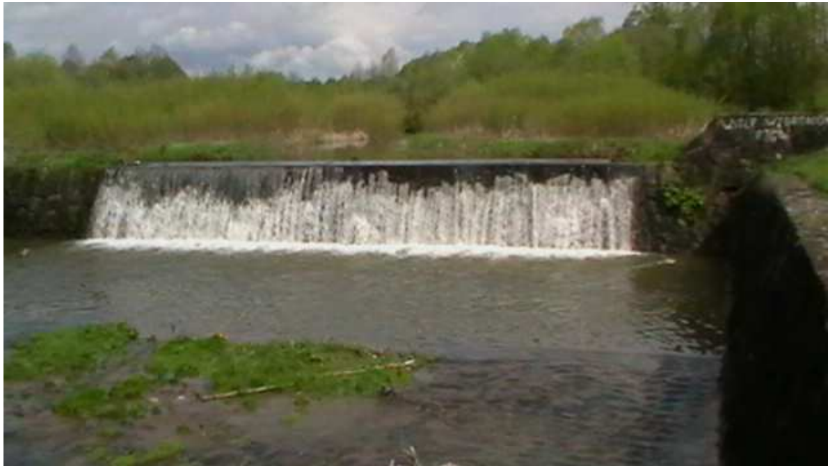
Fot. 10. Zapora kamiennie betonowa na potoku Syhlec
