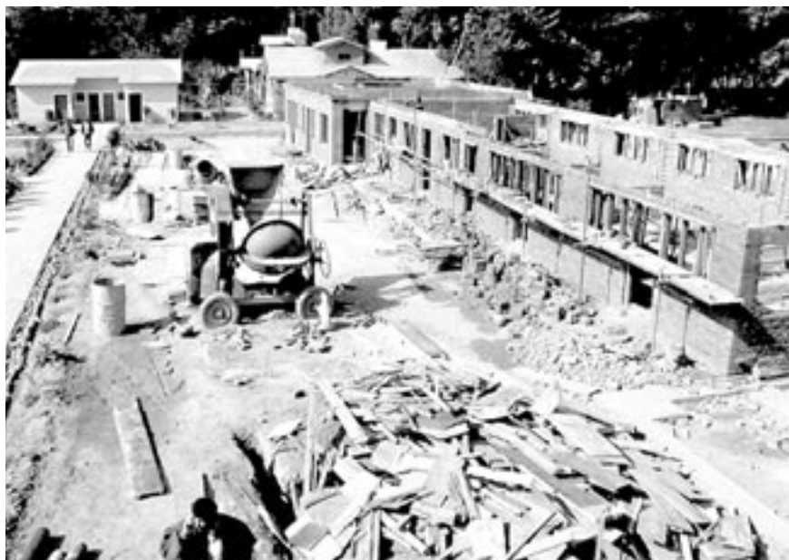
Der Bau eines neuen Patientenhauses (re.) begann im September 2000
