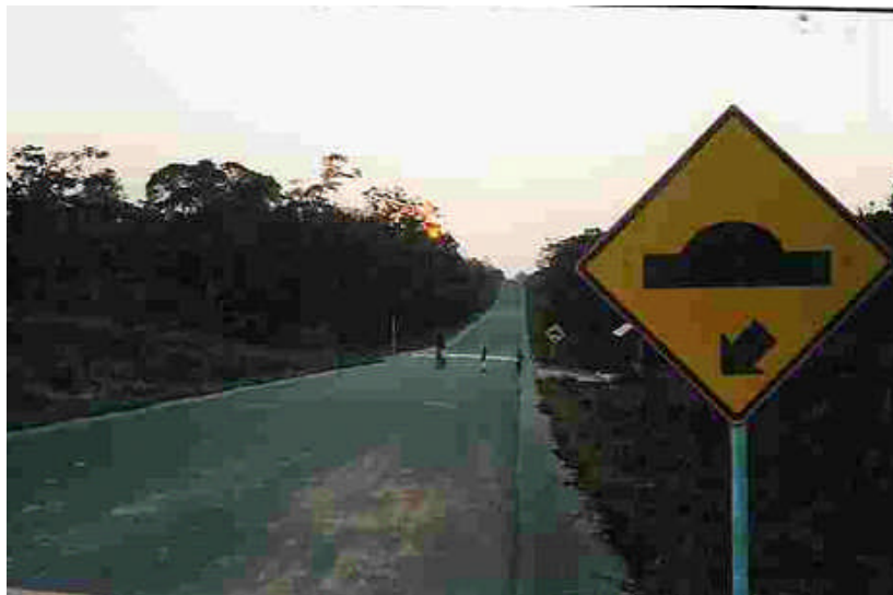
Foto 10: a BR-364, que atravessa a T.I. do rio Campinas
