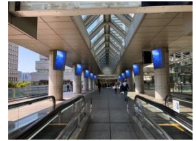
屋外（ランドマークタワー3階外構）
