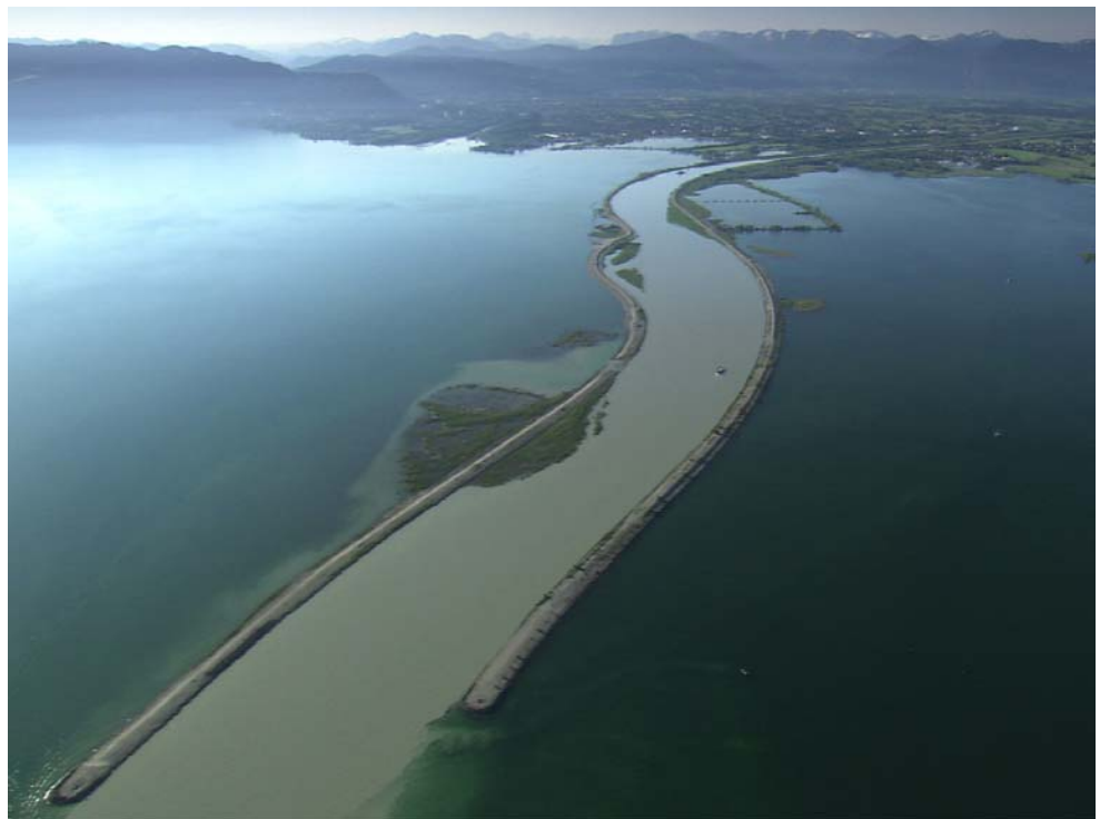
Abb 29: Seit den 1970er Jahren wurden die Rheindämme rund 5 km in den Bodensee vorgestreckt. Aus ökologischer Sicht ist der Erhalt der Landschaftsdynamik von besonderer Bedeutung. Durch Revitalisierungsmaßnahmen soll der derzeit „sehr technische“ Rheinkanal mittelfristig ein naturnäheres Erscheinungsbild erhalten. (Foto: Hanno Thurnher Filmproduktion).
