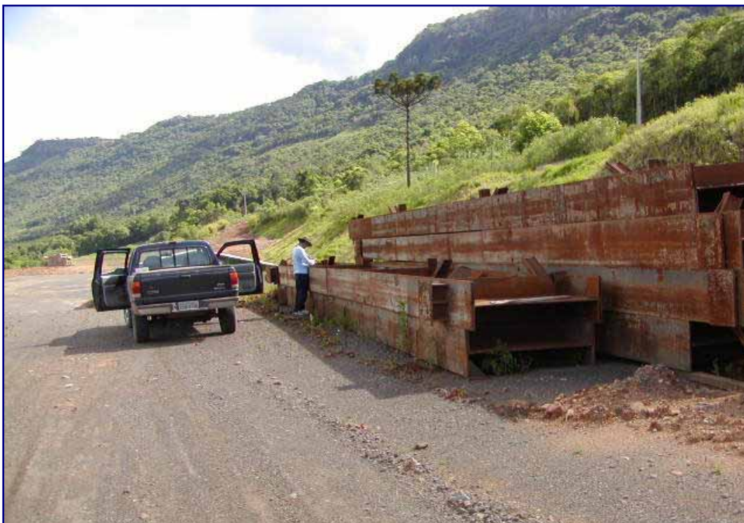
Foto 2: formas para vigas
