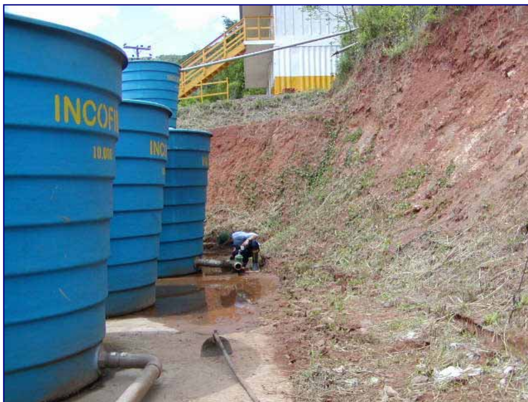
Foto 6: poças de água junto aos reservatórios
